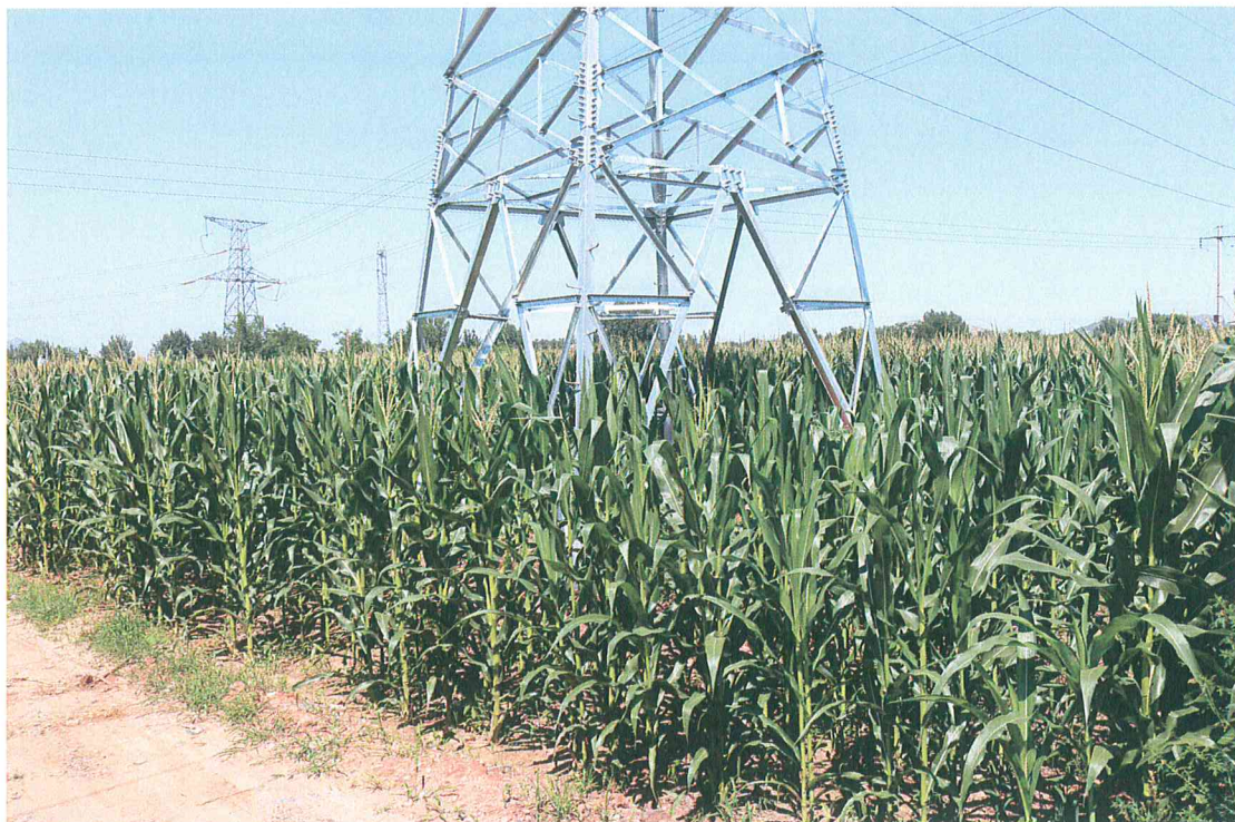
线路塔基区表土清理及土地整治
