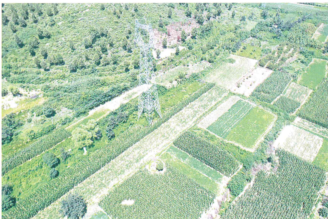
线路塔基区表土清理及土地整治
