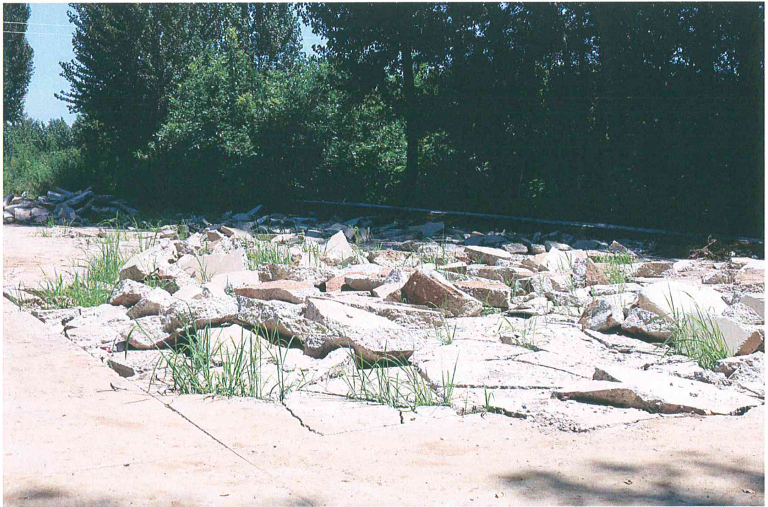
施工生产生活区临建拆除中
