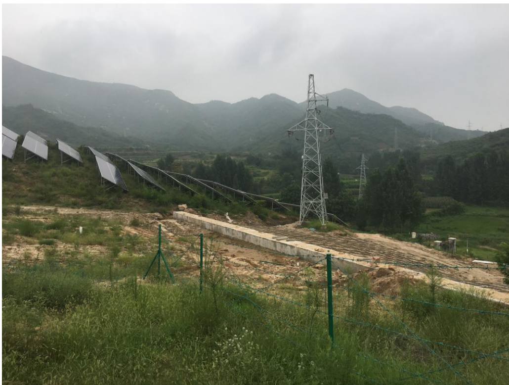
光伏站场区混凝土挡墙
