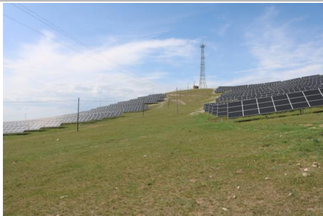
缓坡上光伏区植被恢复
