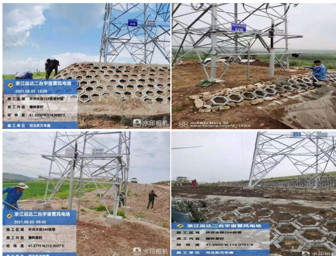
集电线路铁塔整治
