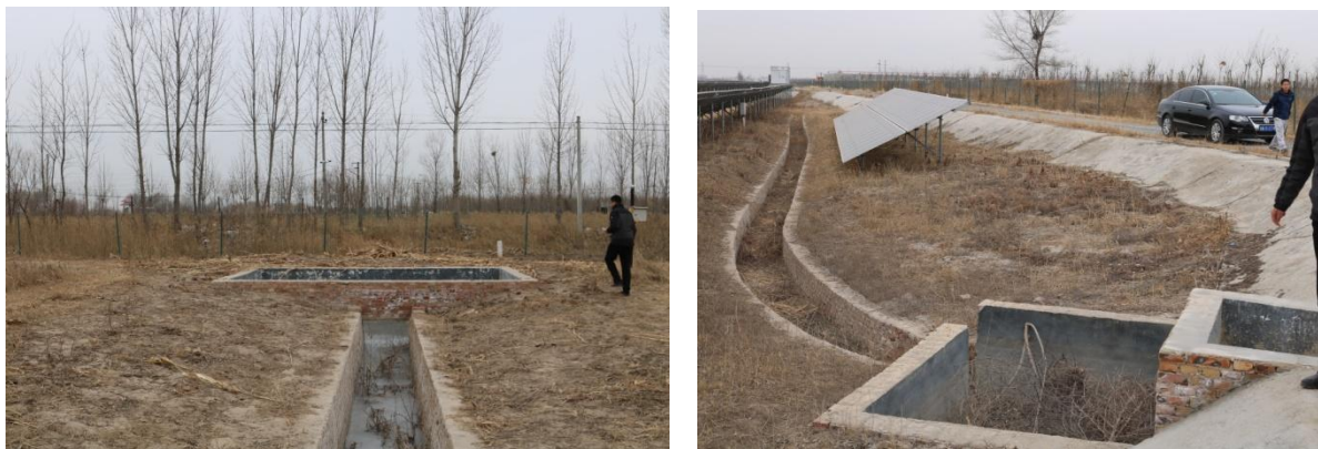
图 4-5 光伏架设区内砖砌集水池
