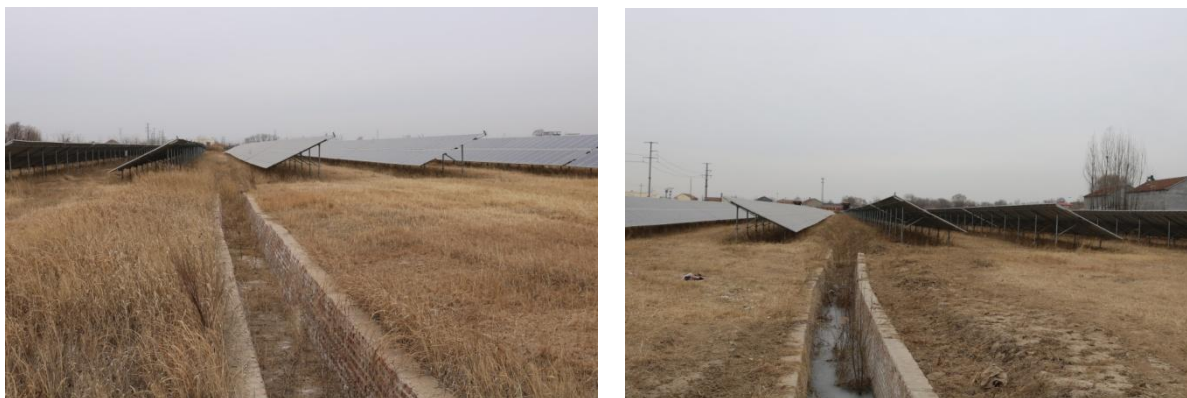
图 4-3 光伏架设区内砖砌防洪沟
