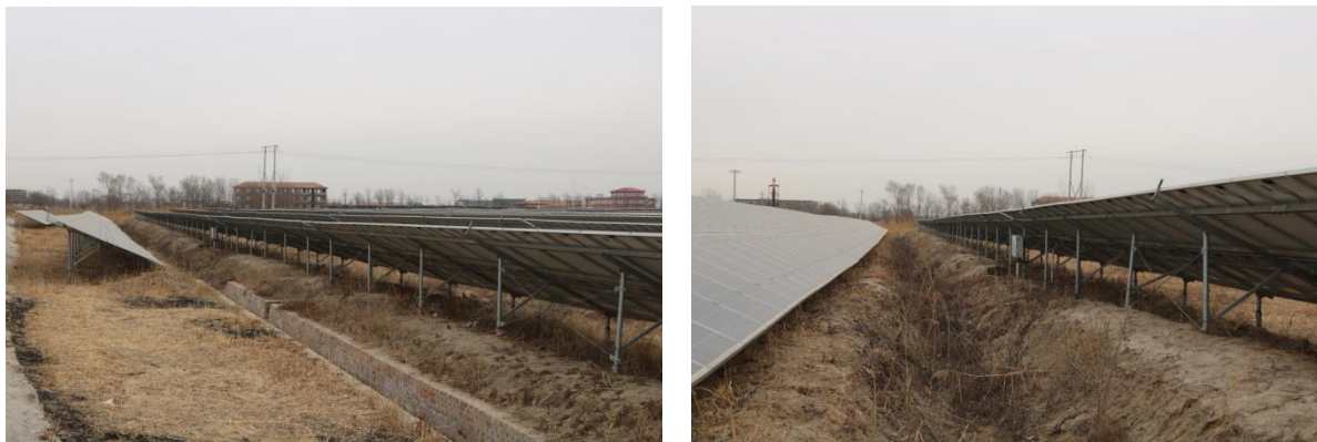
图 4-4 光伏架设区内土质排水沟
