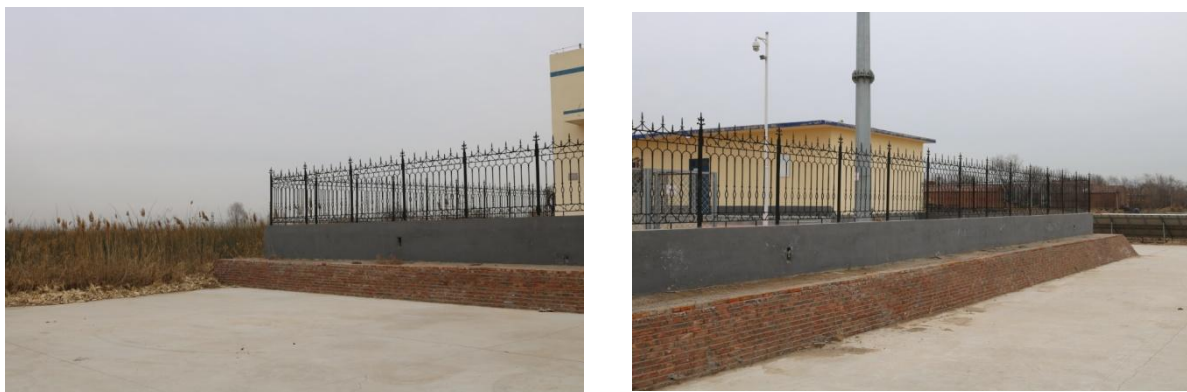
图 4-6 开关站砖砌护坡
