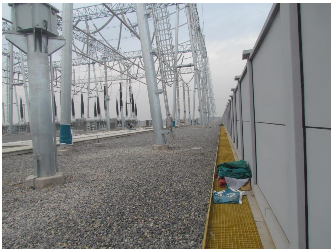
配电装置区碎石压盖（2017 年 11 月）
