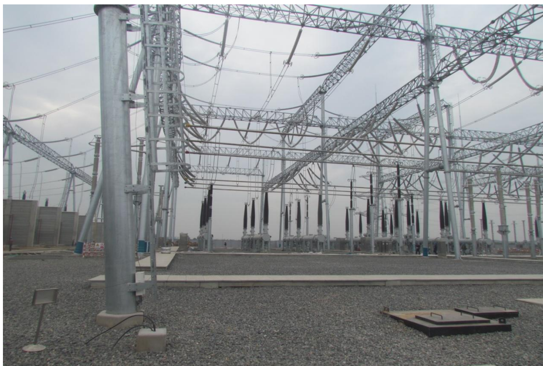
配电装置区碎石压盖（2018 年 2 月）
