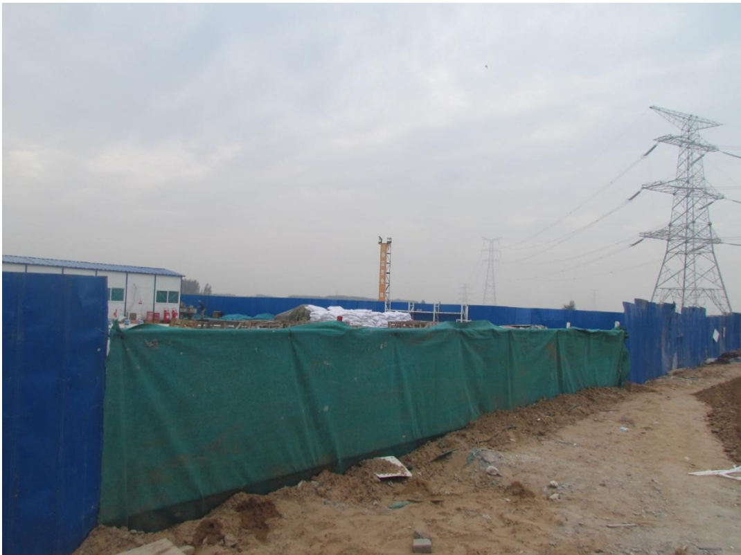
施工生产区彩钢板拦挡（2017 年 11 月）
