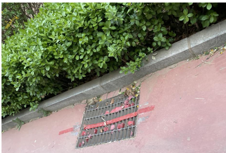
雨水排水管道及绿化 (2023.8.9)
