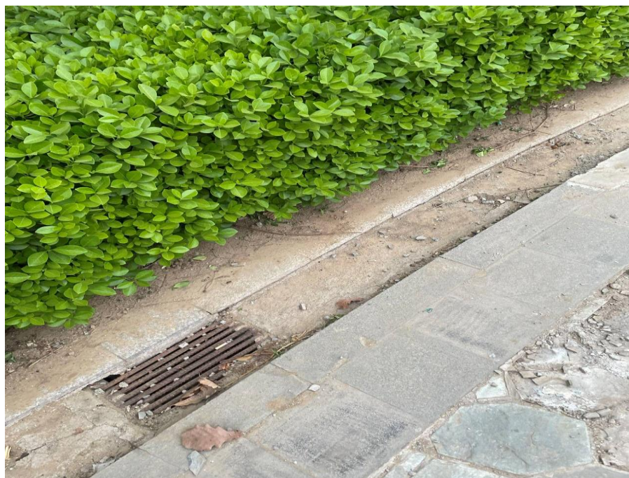
雨水排水管道及绿化 (2023.8.9)
