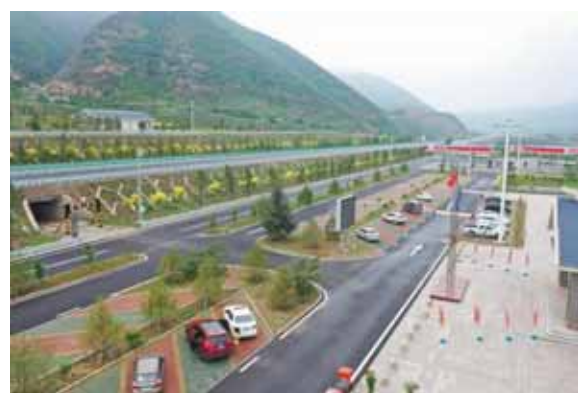
沿线设施区坡面防护、排水工程、绿化工程
