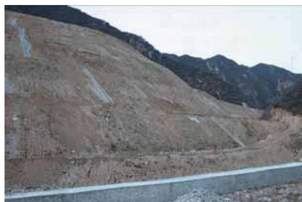
3、ZT1-松山 斜井弃渣场
