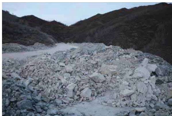
13、Y2-东底梁 出口、斜井弃渣场
