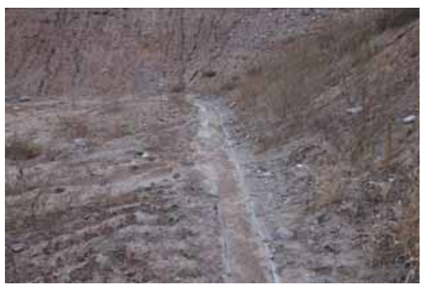
2、ZT1- 泉口 入口弃渣场
