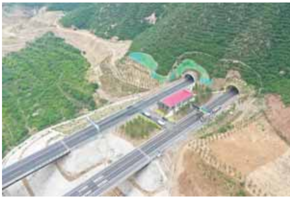
隧道工程区洞口坡面防护、截排水工程、植被恢复
