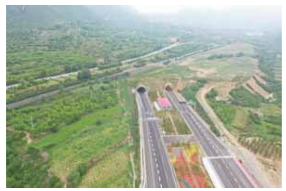
隧道工程区洞口坡面防护、截排水工程、植被恢复
