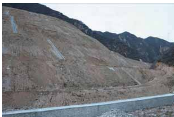
3、ZT1-松山 斜井弃渣场
