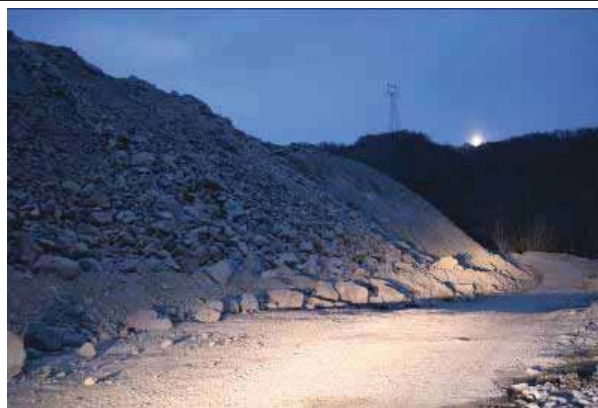
14、Y3-洞头营 入口弃渣场
