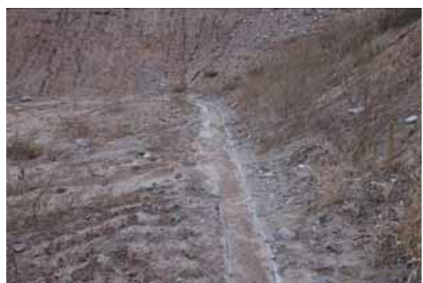
2、ZT1- 泉口 入口弃渣场
