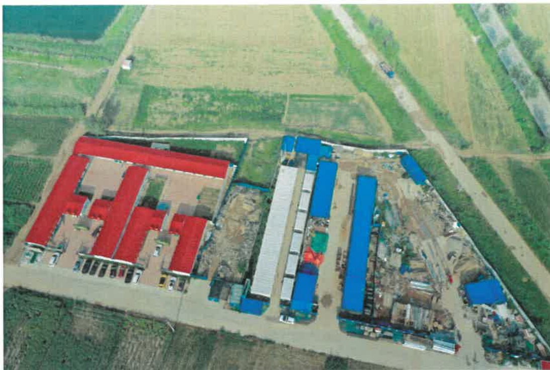
施工生产生活区透水砖等临时措施
