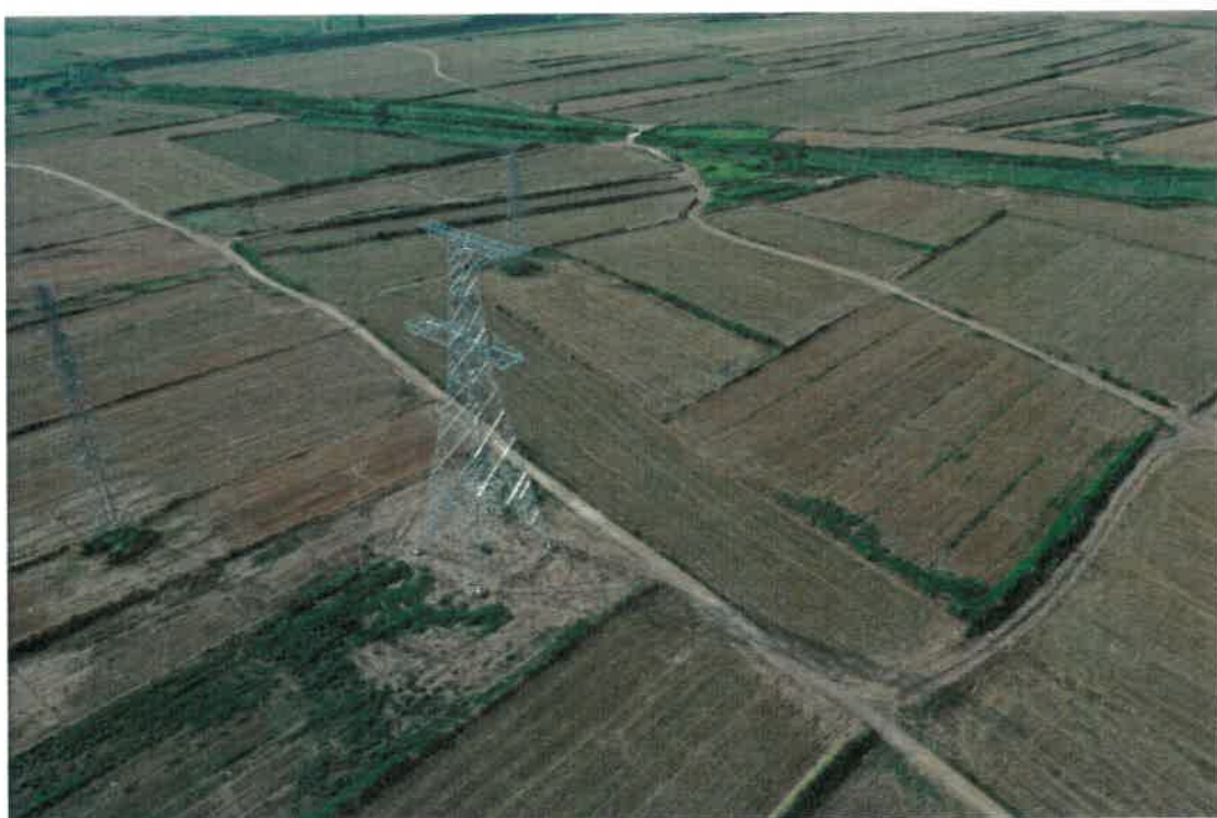
塔基施工区完成整地
