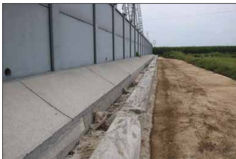
透水孔+围墙外修建混凝土排水沟
