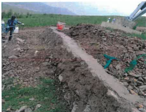
塔基区浆砌石挡墙
