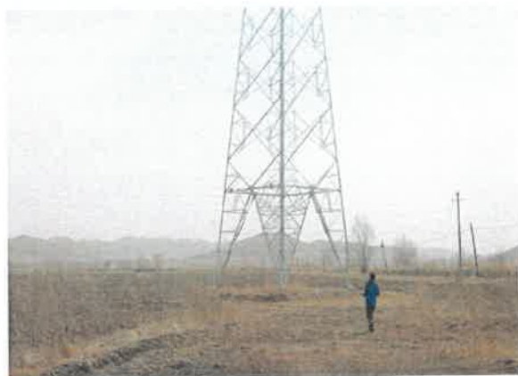
施工便道土地整治
