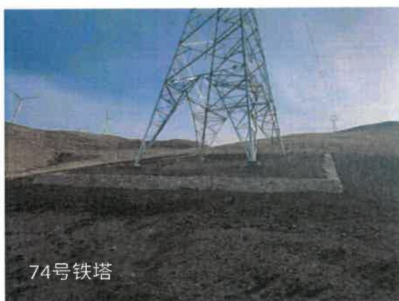
塔基区浆砌石挡墙
