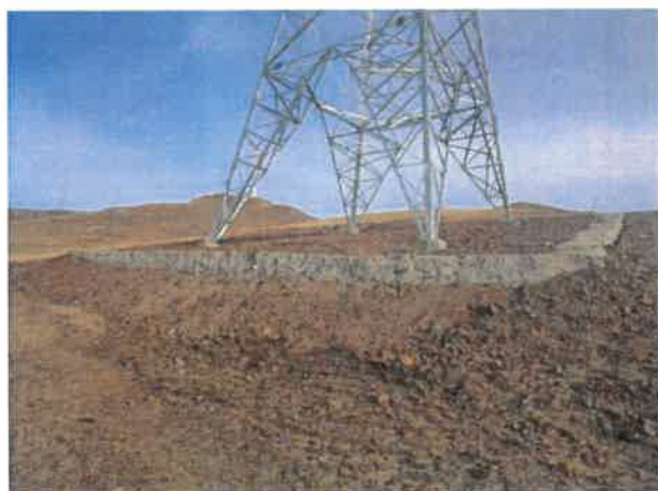
塔基区浆砌石挡墙
