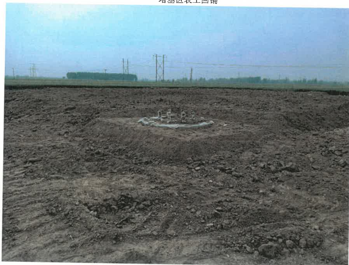
塔基区表土回铺
