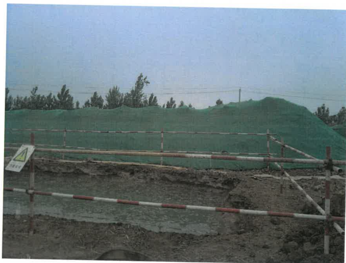
临时遮盖措施
