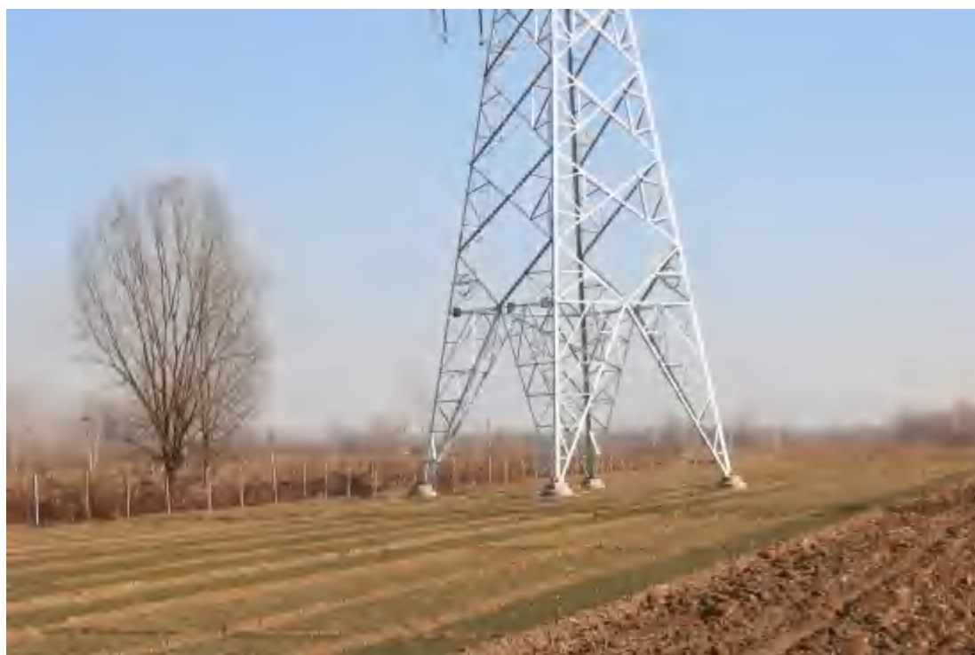
塔基区整地后复耕（2022.12）
