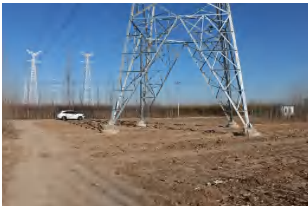
塔基区整地后复耕（2022.12）
