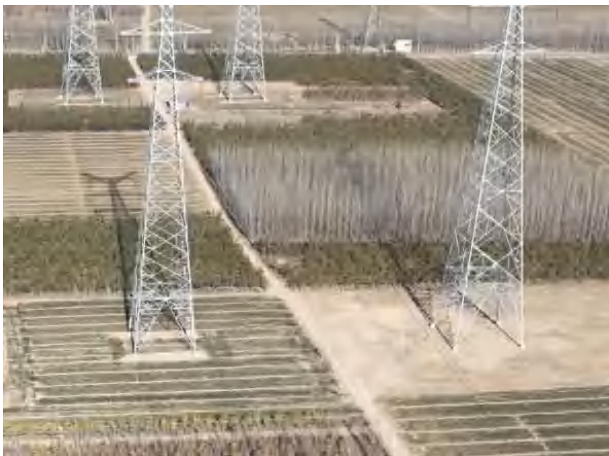
塔基区整地后复耕（2022.12）
