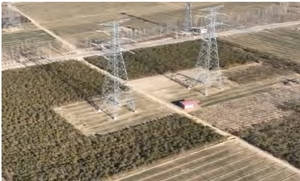
塔基区整地后复耕（2022.12）
