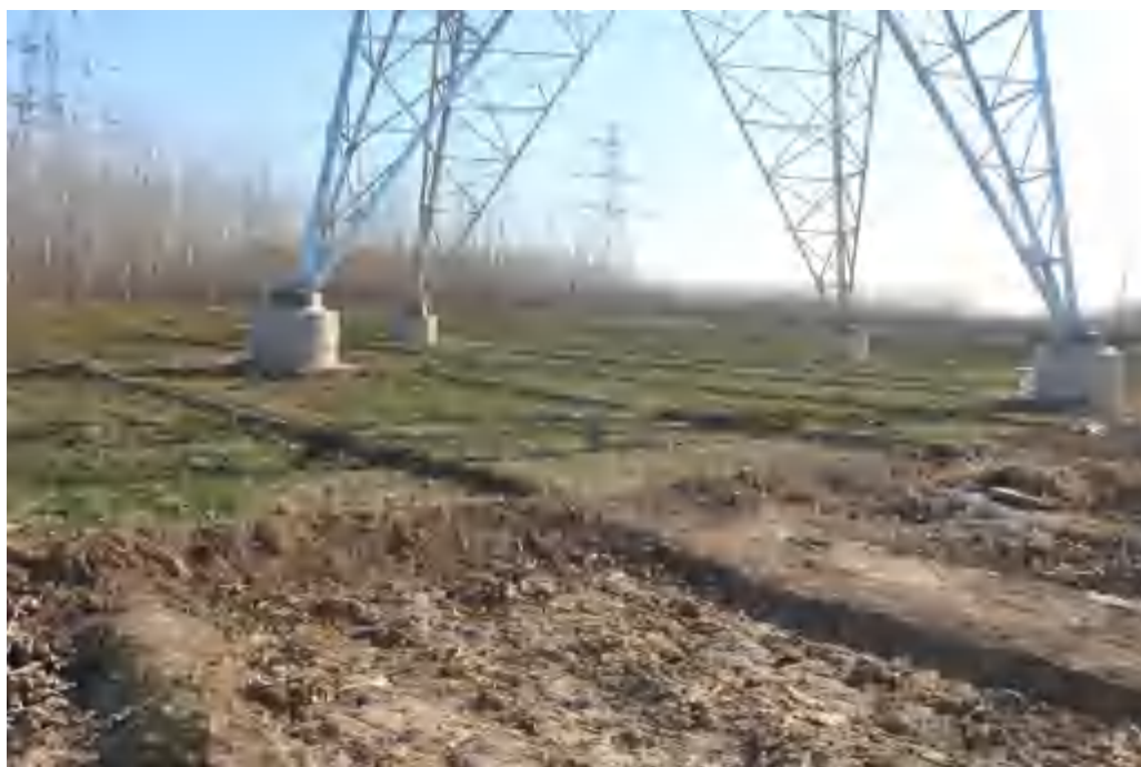
塔基区整地后复耕（2022.12）
