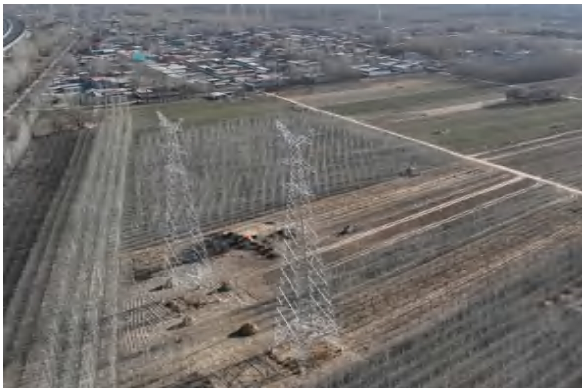
塔基区整地后复耕（2022.12）
