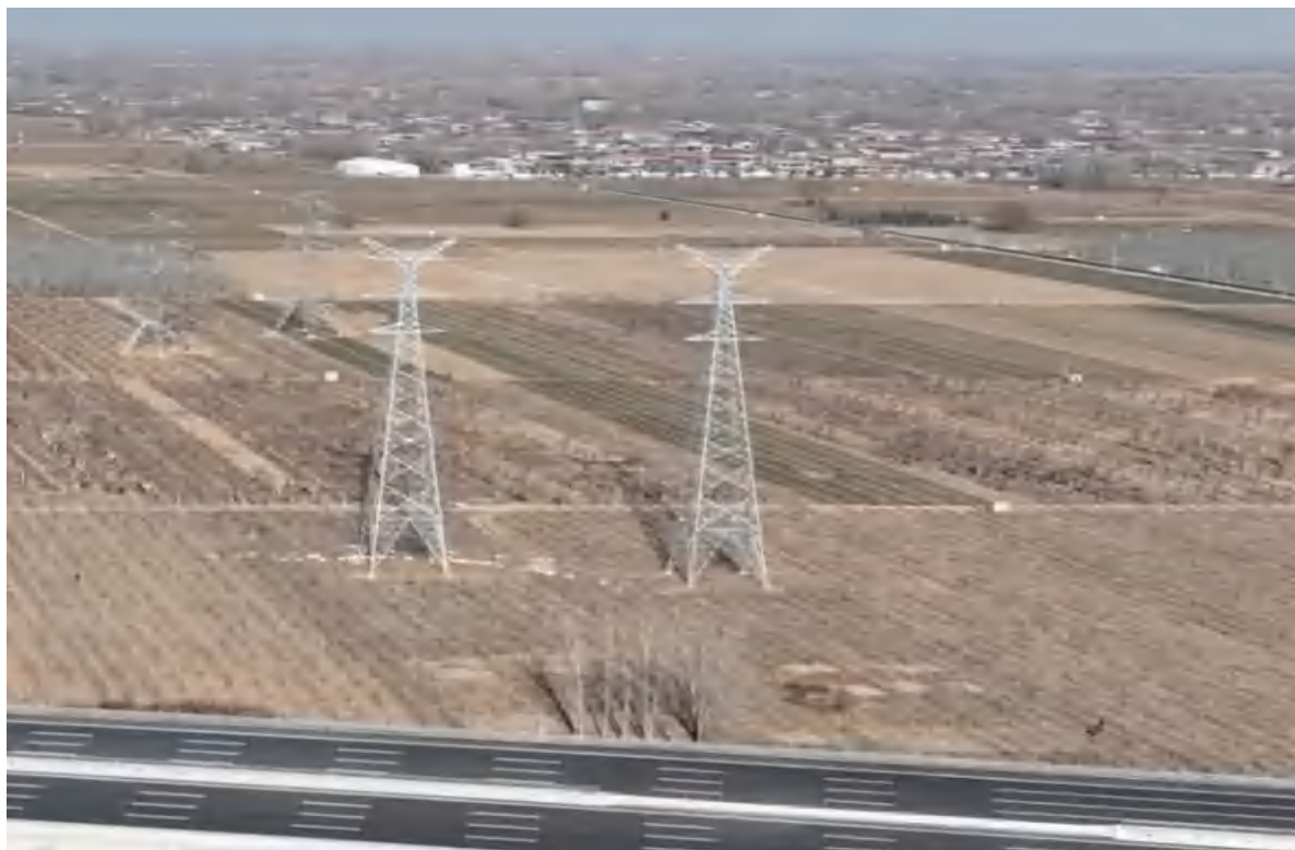
塔基区整地后复耕（2022.12）
