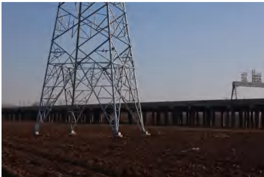
塔基区整地后复耕（2022.12）
