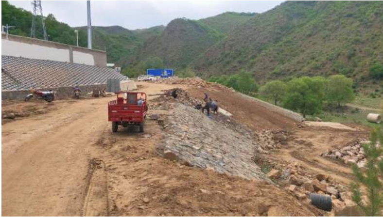
升压站边坡防护施工（浆砌石护坡及六棱砖护坡）
