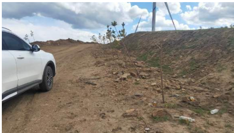
道路（水蚀冲蚀沟）此处需要修建截排水沟
