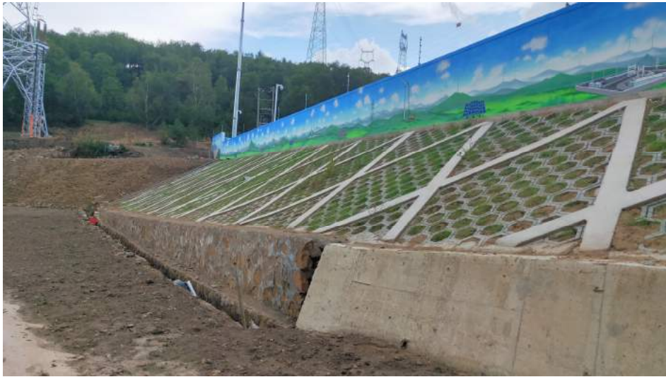
升压站浆砌石排水沟和框格护坡（植草砖，2023年9月）
