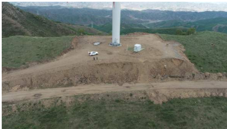
风机区风机吊装场平整及边坡情况（航拍）需要尽快整治边坡，恢复植被
