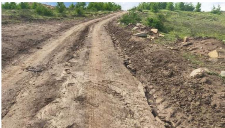
道路（水蚀冲蚀沟）此处需要修建截排水沟
