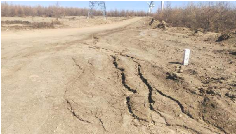
道路及电缆沟（水蚀冲蚀沟）
