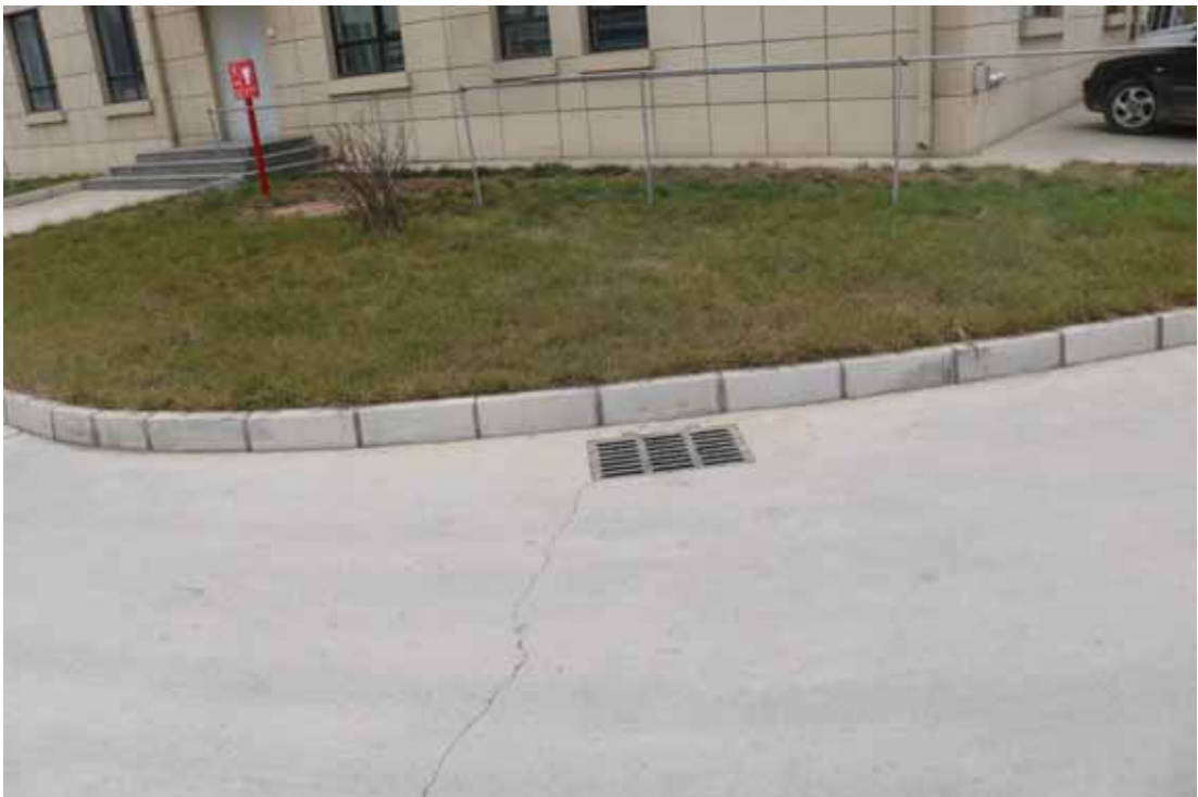
构建筑物区雨水排水管道及绿化
