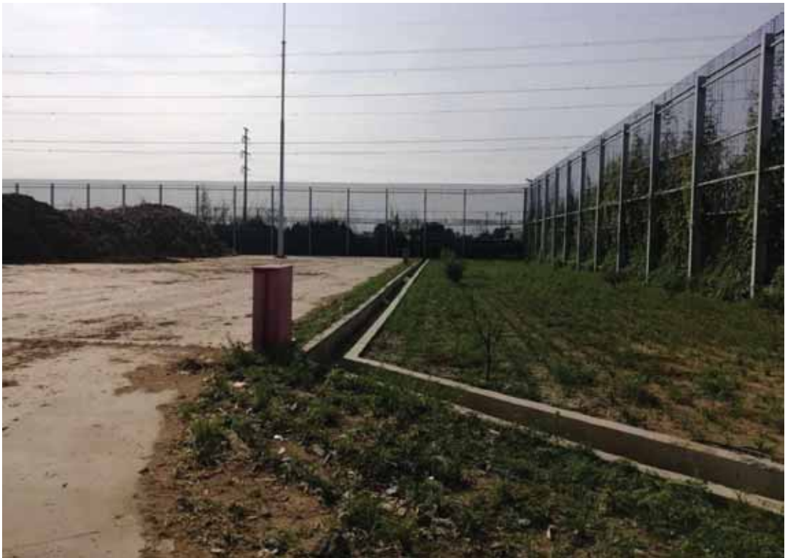
燃料设施区排水沟及绿化
