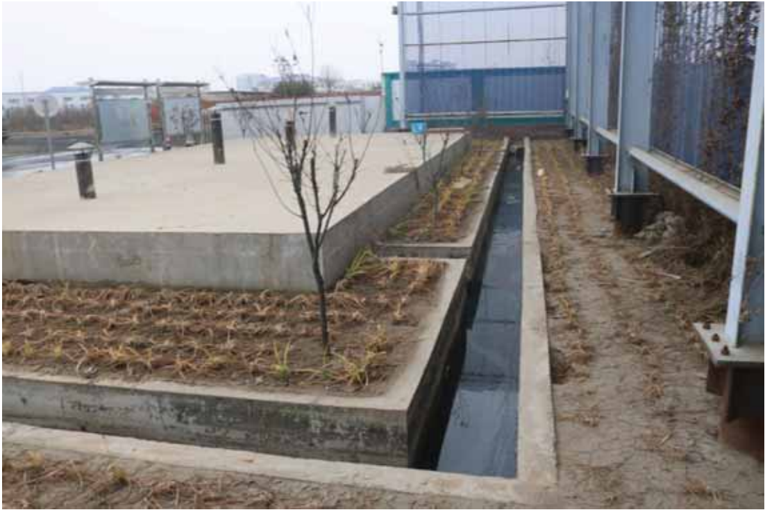
燃料设施区排水沟及绿化
