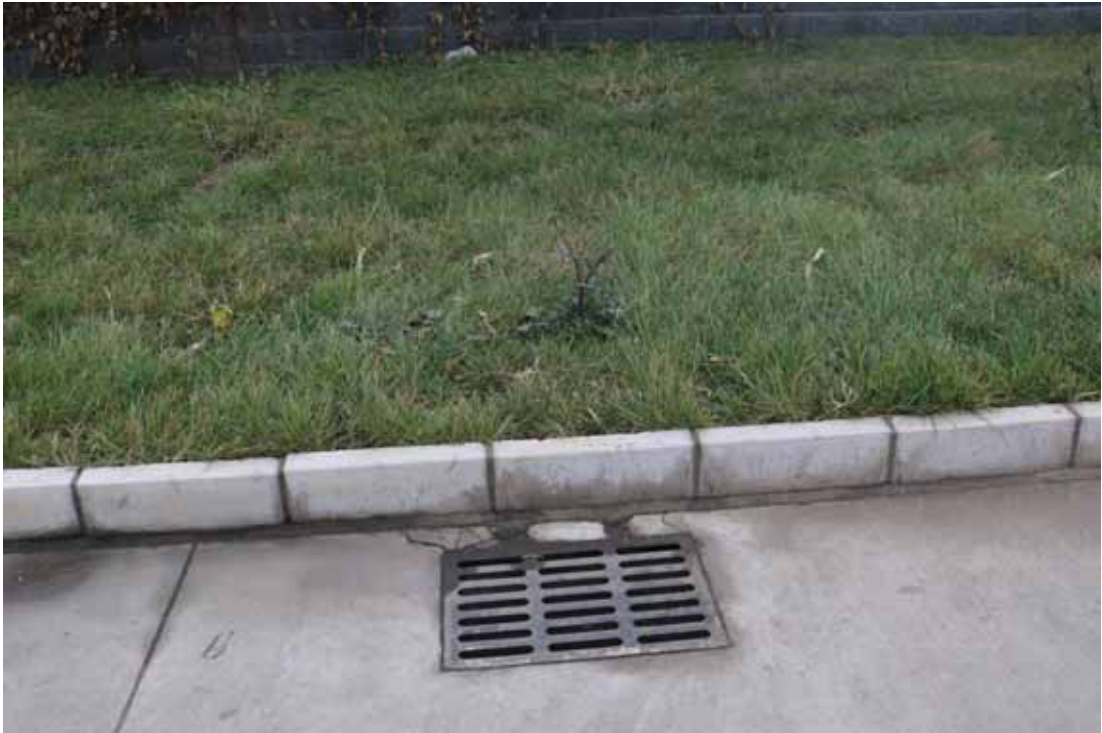
构建筑物区雨水排水管道及绿化
