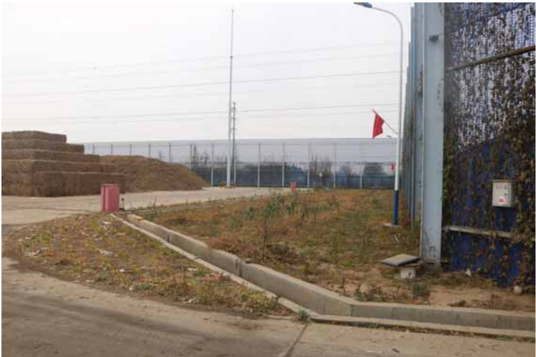
燃料设施区排水沟及绿化
