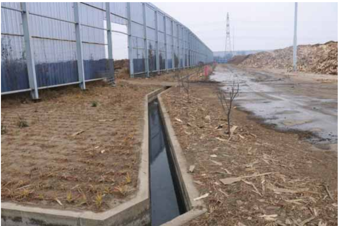
燃料设施区排水沟及绿化
