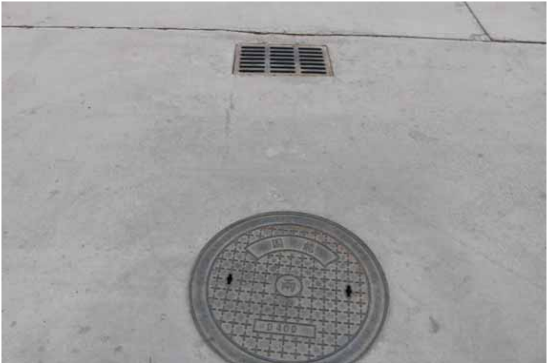
构建筑物区雨水排水管道
