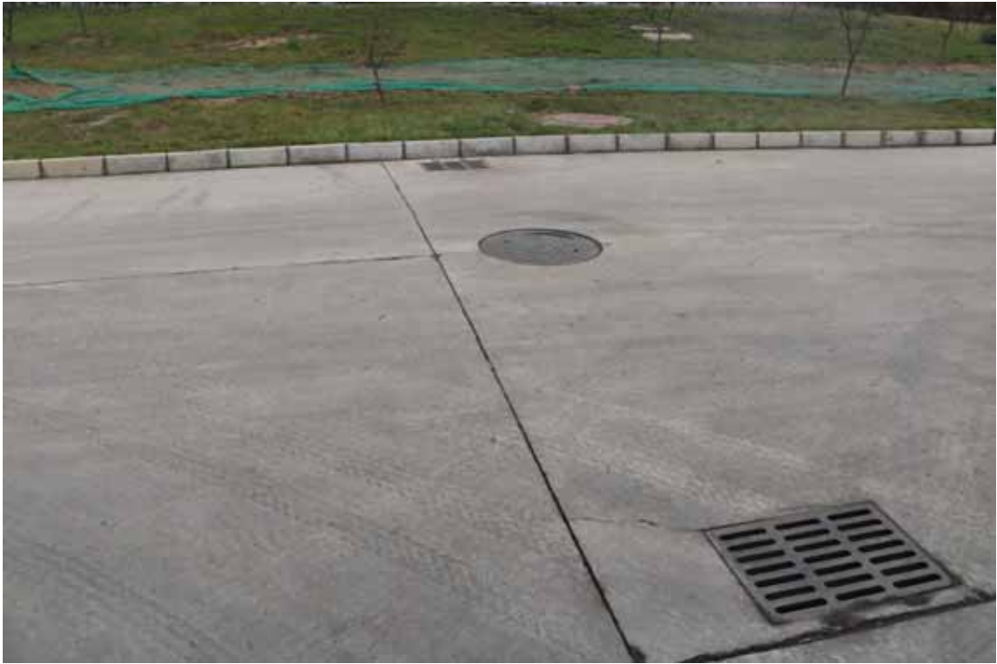
构建筑物区雨水排水管道及绿化
