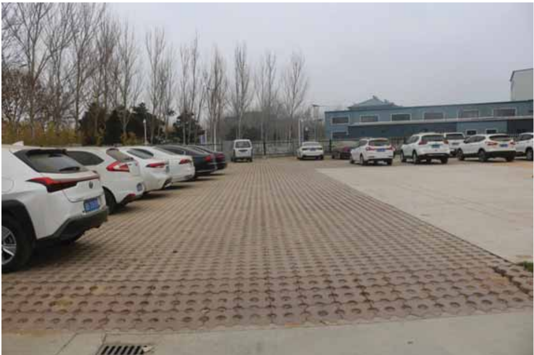
构建筑物区透水砖
