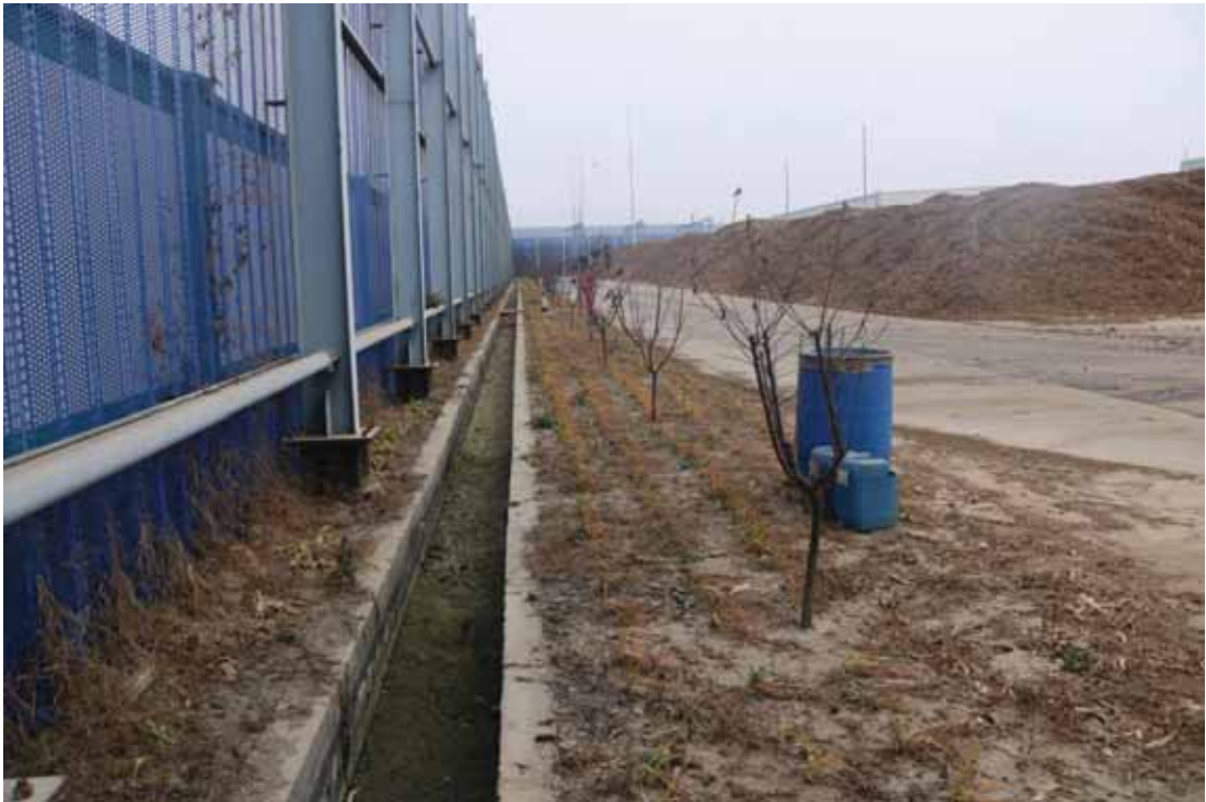
燃料设施区排水沟及绿化
