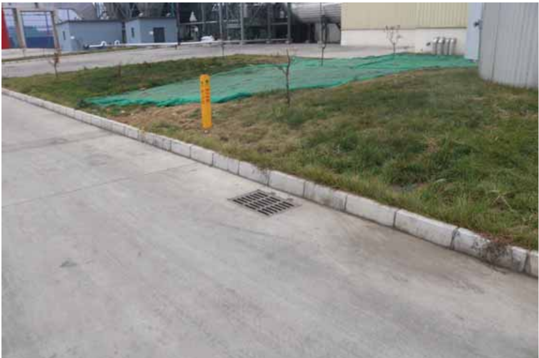
构建筑物区雨水排水管道及绿化
