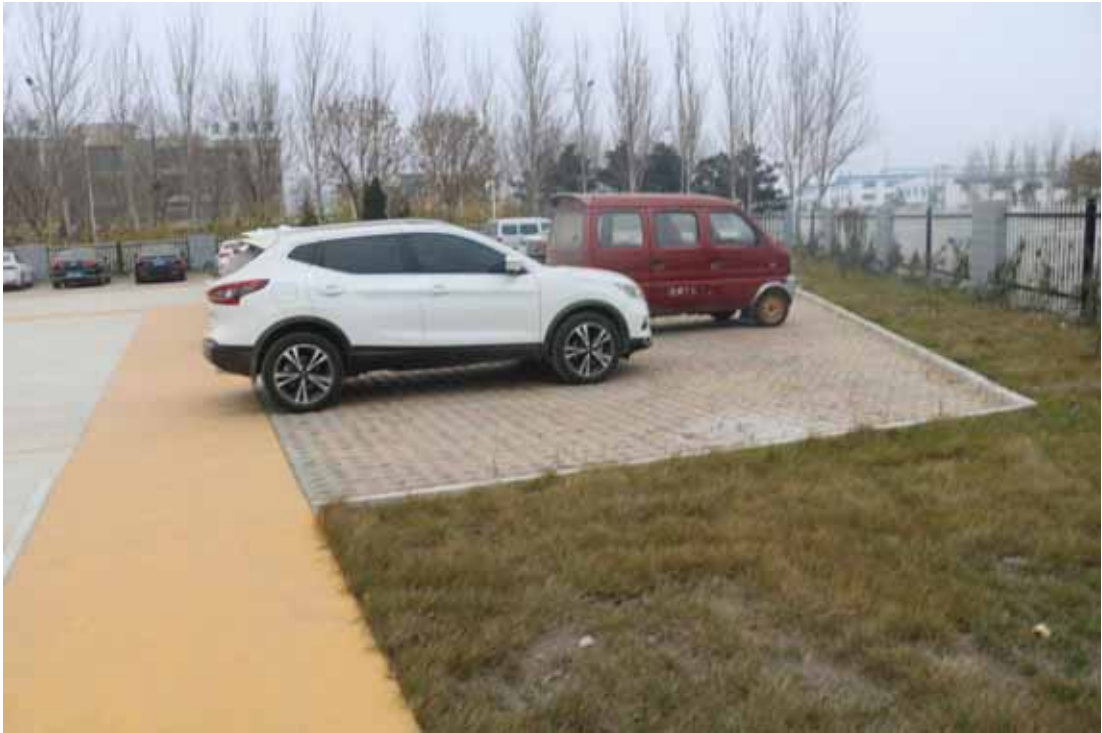
构建筑物区透水砖及绿化
