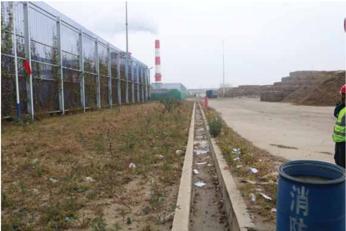
燃料设施区排水沟及绿化
