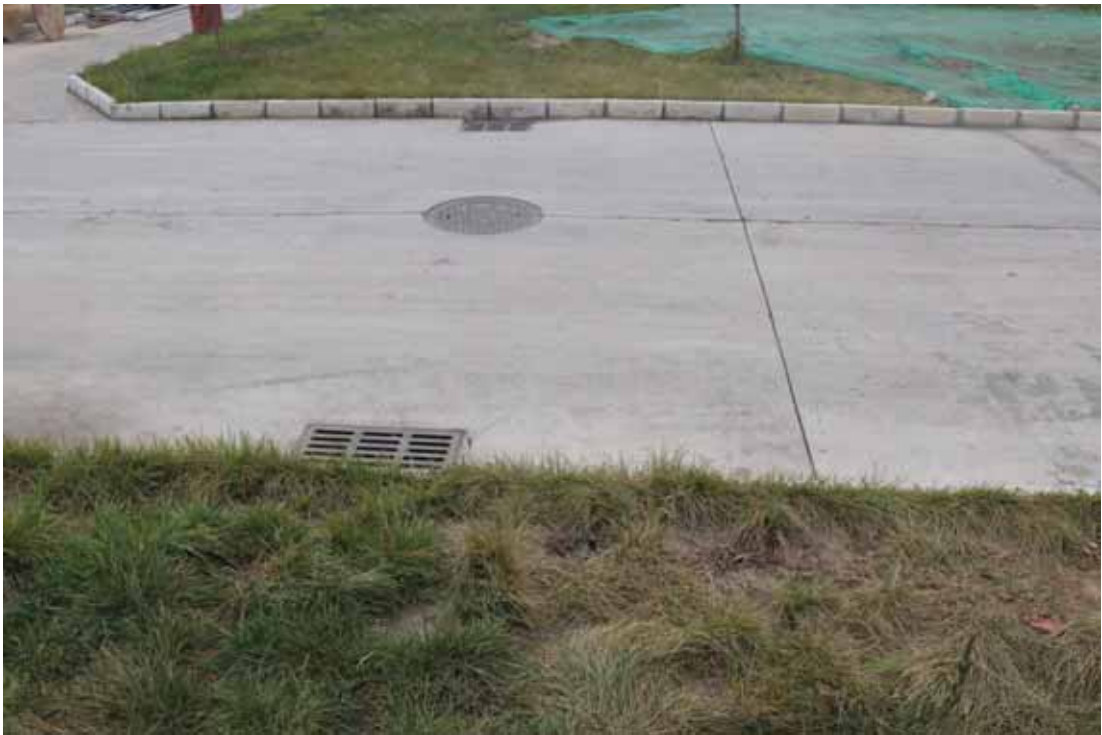
构建筑物区雨水排水管道及绿化
