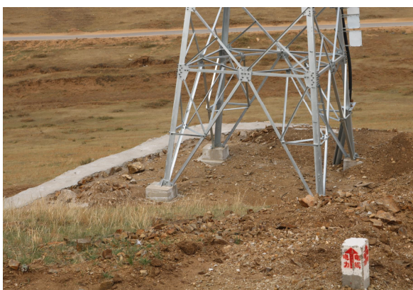
集电线路浆砌石护坡措施(2018 年 5 月)
