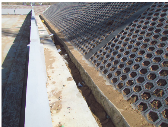
220kV 升压站排水管沟(2018 年 10 月)
