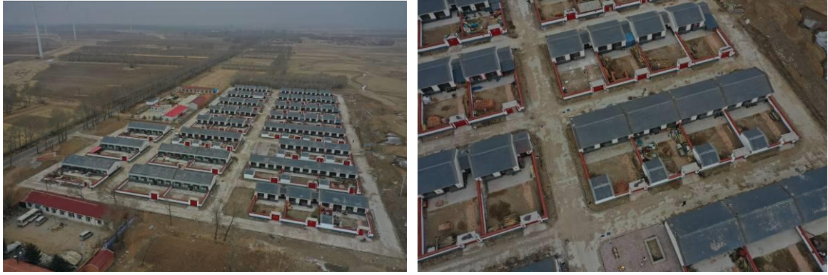
图 2-2 工程建设现状图
