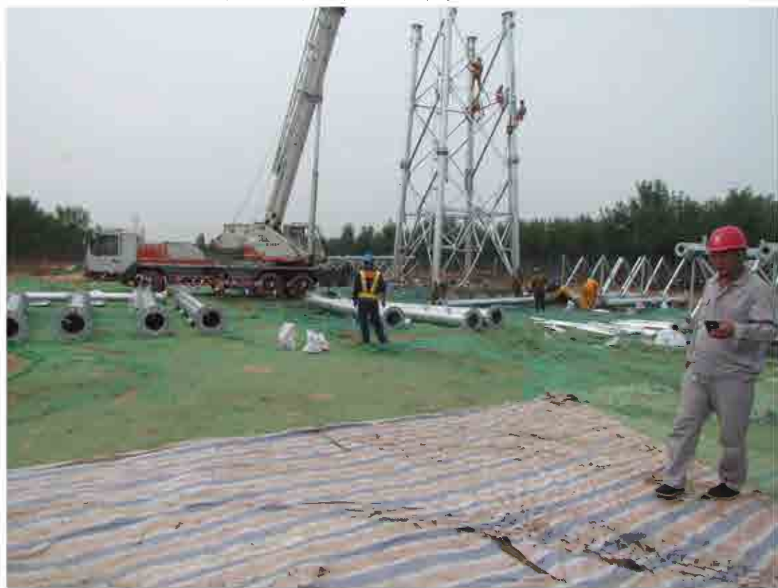
线路施工区临时遮盖、彩条布铺垫（2019.7.18）
