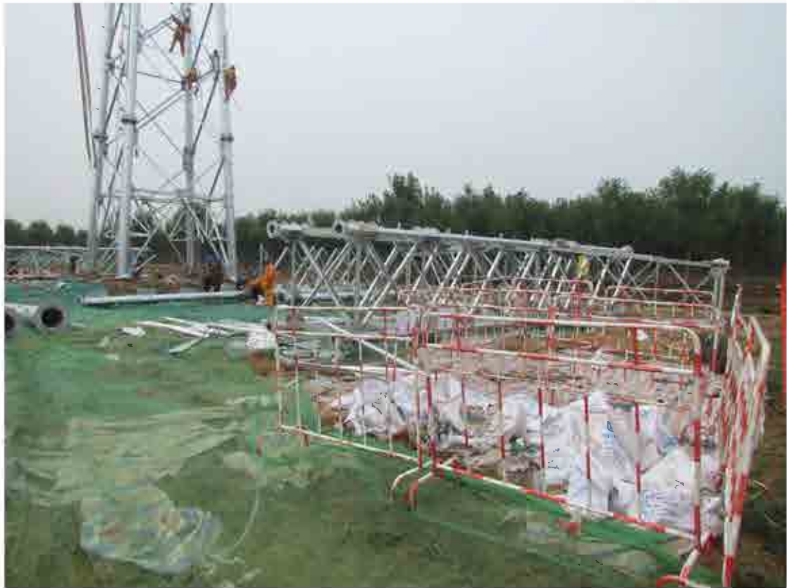
线路施工区临时遮盖、彩条布铺垫（2019.7.18）
