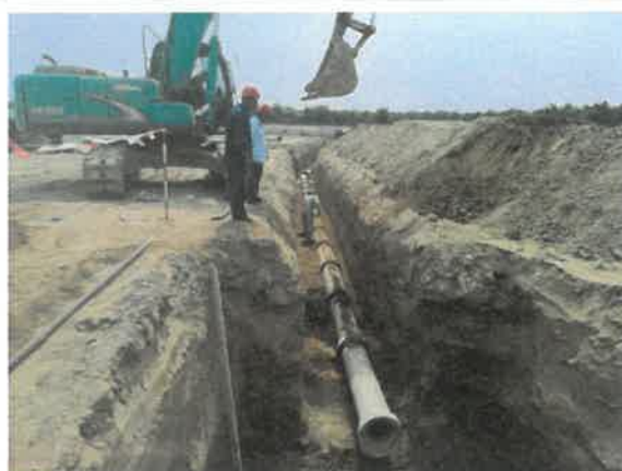
塔基施工现场及进站道路排水管修建
