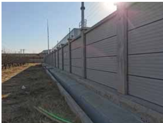
变电站混凝土排水沟
