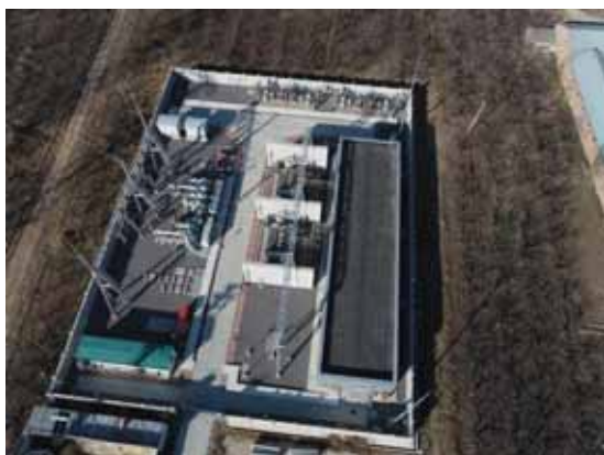
变电站内铺设透水砖、碎石压盖
