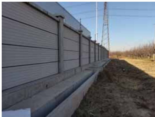
变电站混凝土排水沟
