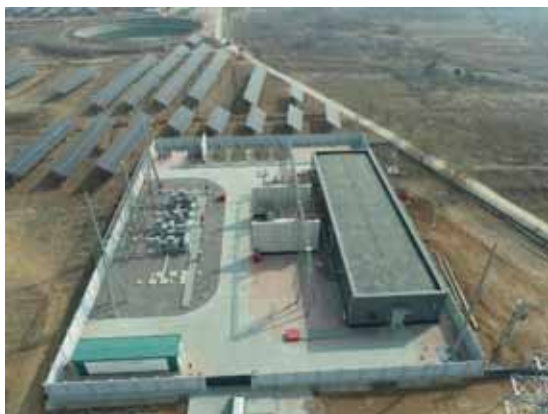
变电站内铺设透水砖、碎石压盖
