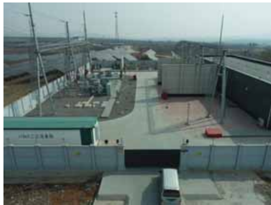
变电站内铺设透水砖、碎石压盖
