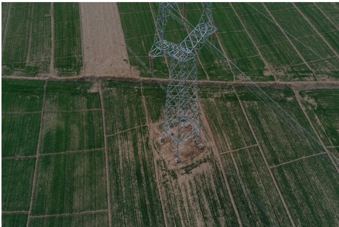
线路塔基、施工区、施工便道已平整（2020.3.20）
