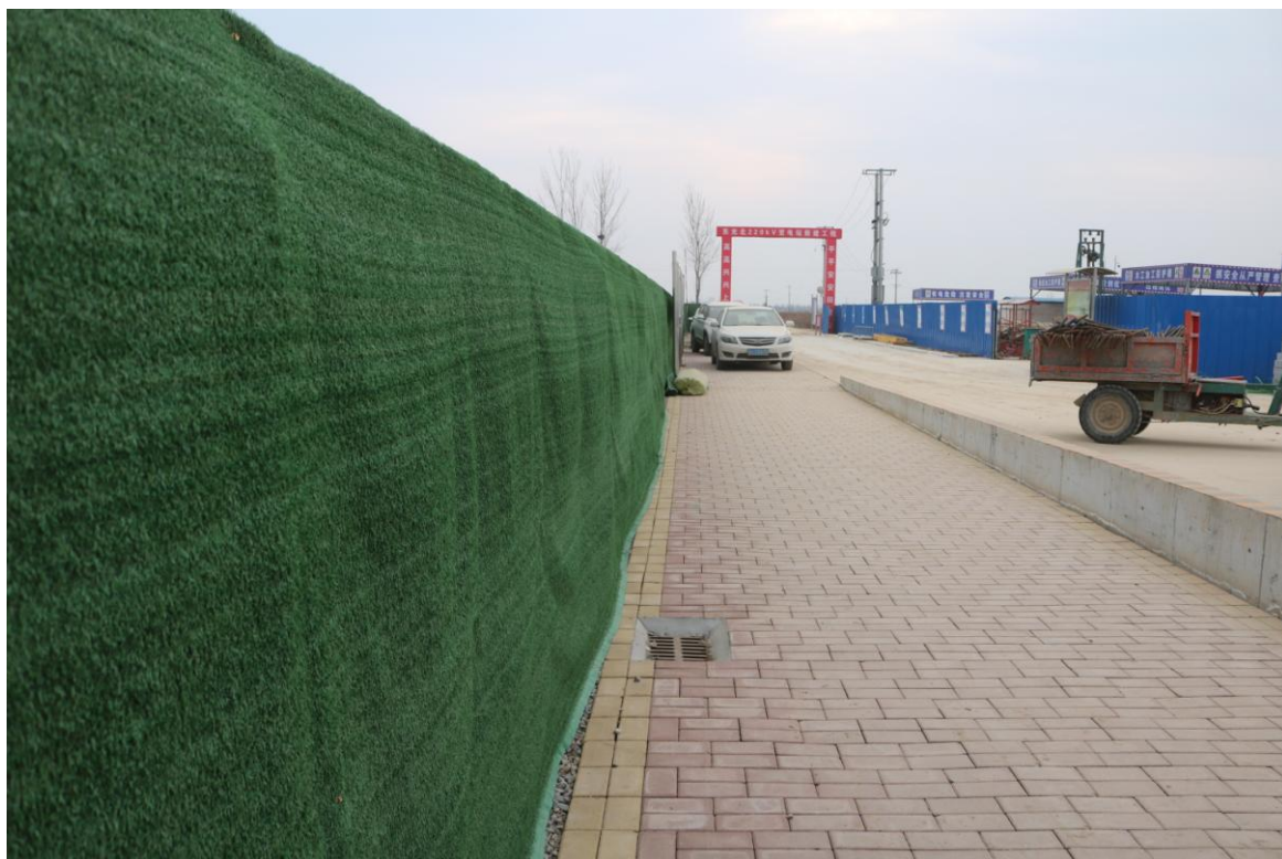
变电站施工生产生活区临时透水砖、排水（2019.11.29）
