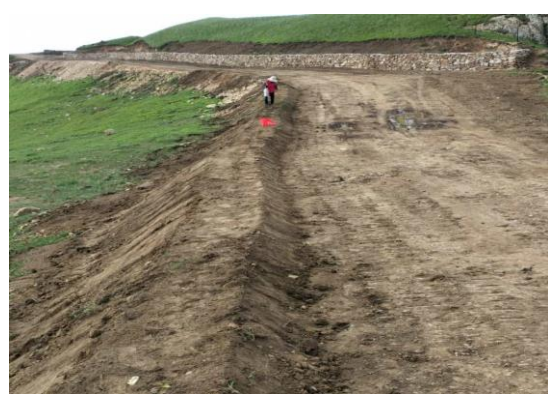
施工检修道路道路边埂、覆土绿化
