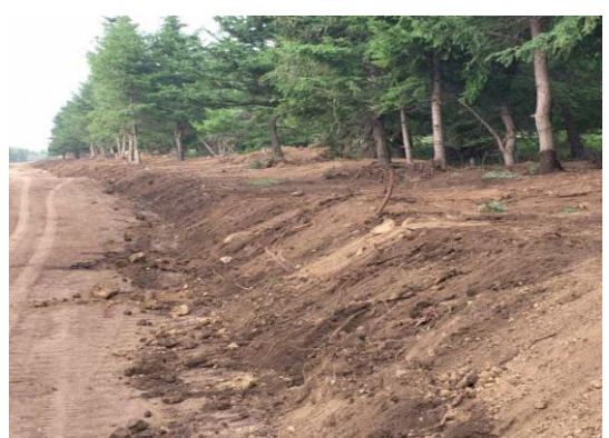
施工检修道路道路边埂、覆土绿化
