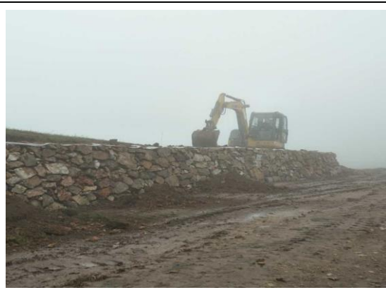
施工检修道路浆砌石排水沟、干砌石挡墙
