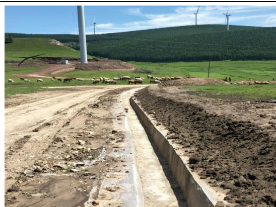
施工检修道路浆砌石排水沟、干砌石挡墙
