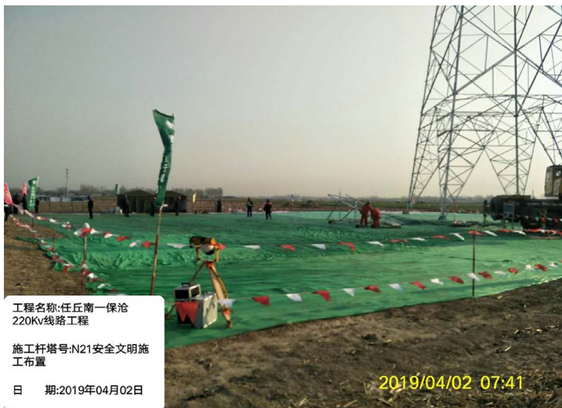
输电线路施工过程中临时遮盖（2019.4.2）
