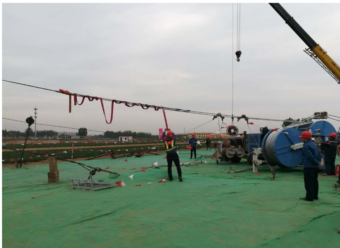
输电线路施工过程中临时遮盖（2019.4.2）
