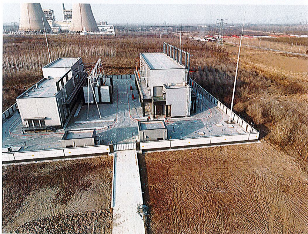
变电站站内已铺设透水砖（2023.2.27）
