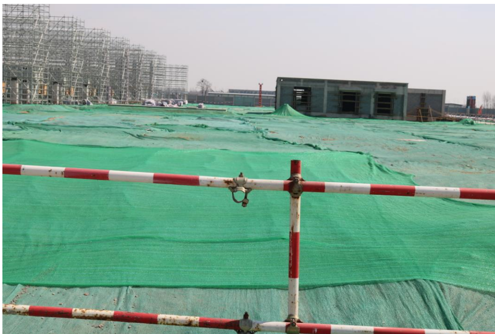
变电站施工临时遮盖(2017 年 3 月)
