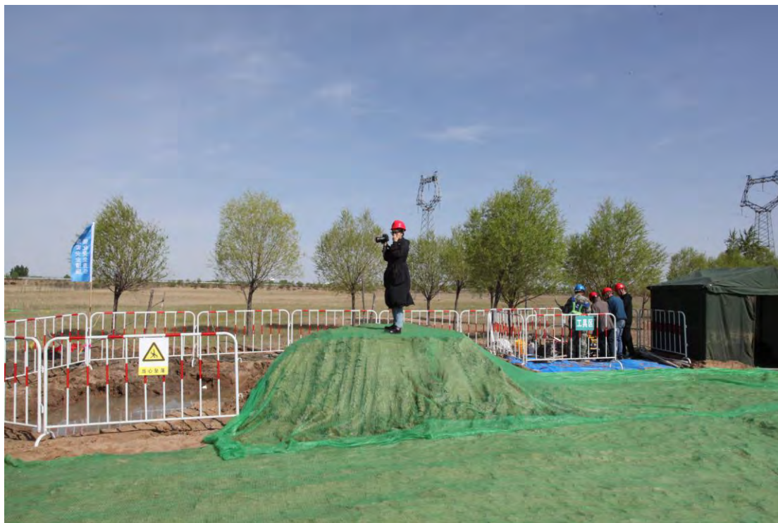
土地整治工程（表土清理）、临时防护工程（临时苫盖）
