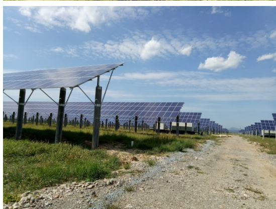
施工检修道路及土质排水沟情况
