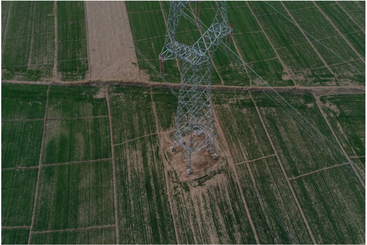
线路塔基区已平整，临时占地已复耕
