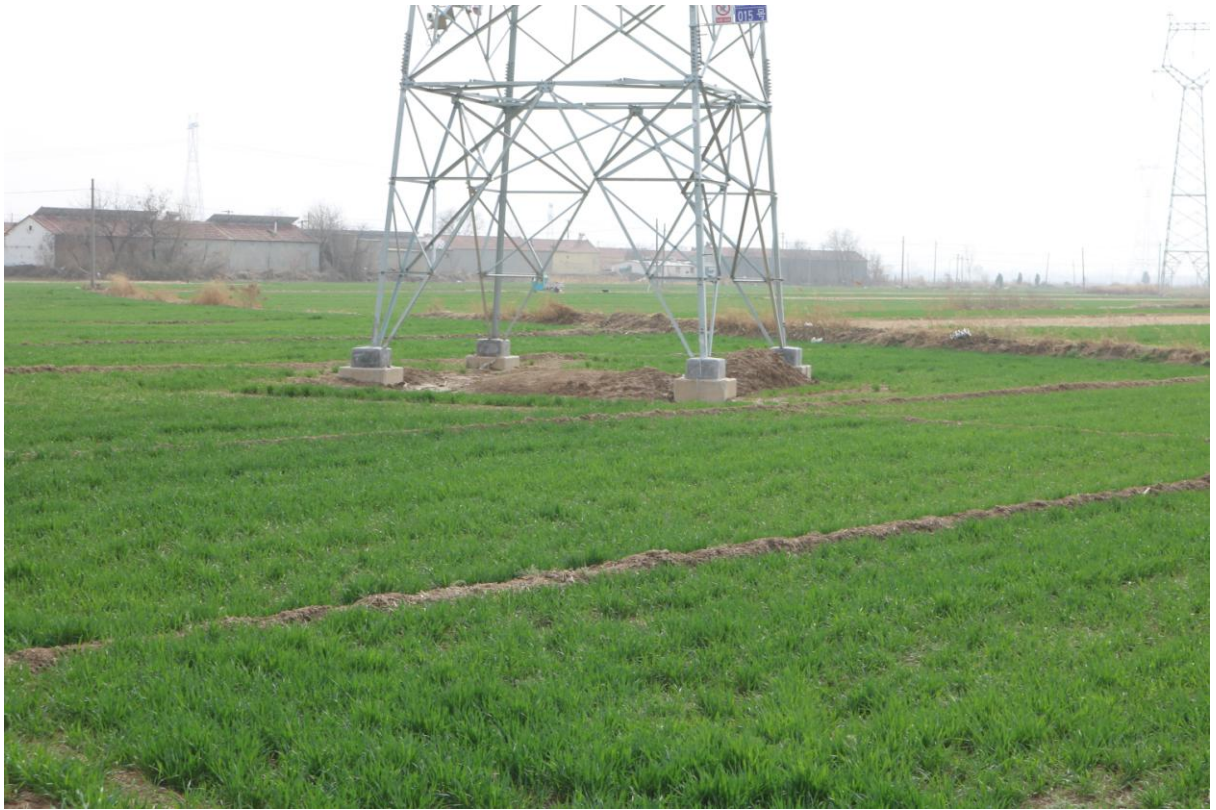
塔基区、线路施工区、施工便道已平整
