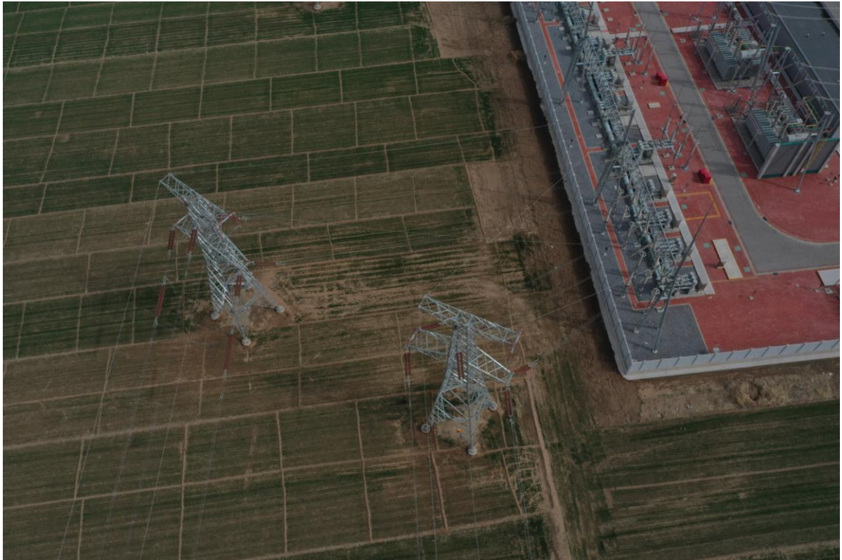
变电站外塔基区、施工区、施工便道已平整
