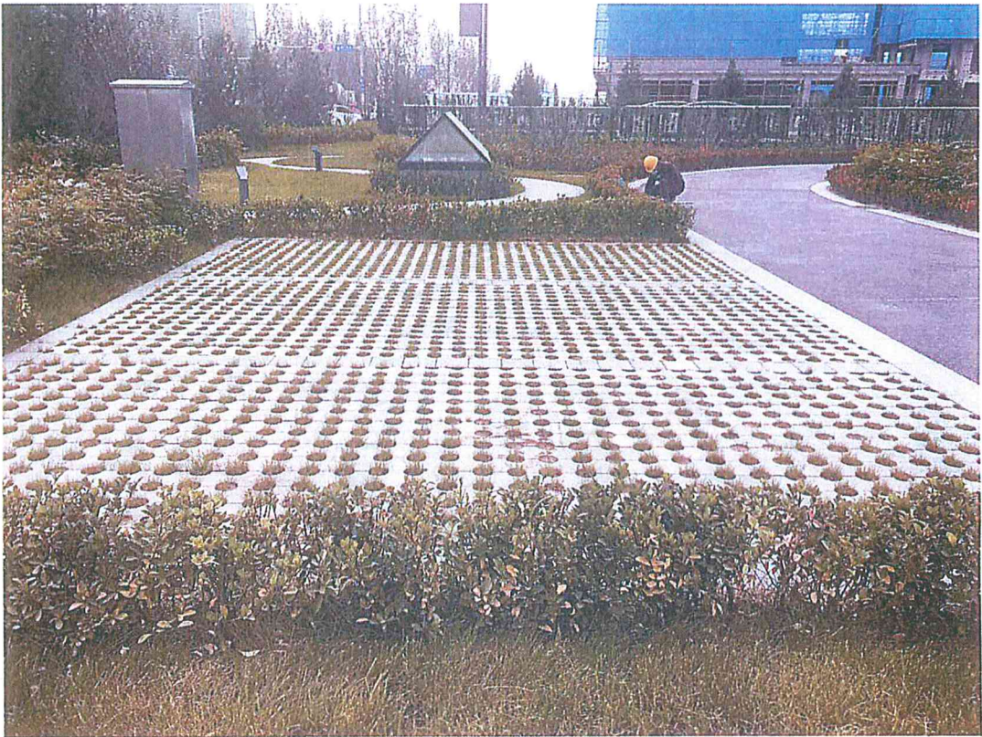
铺空心砖措施
