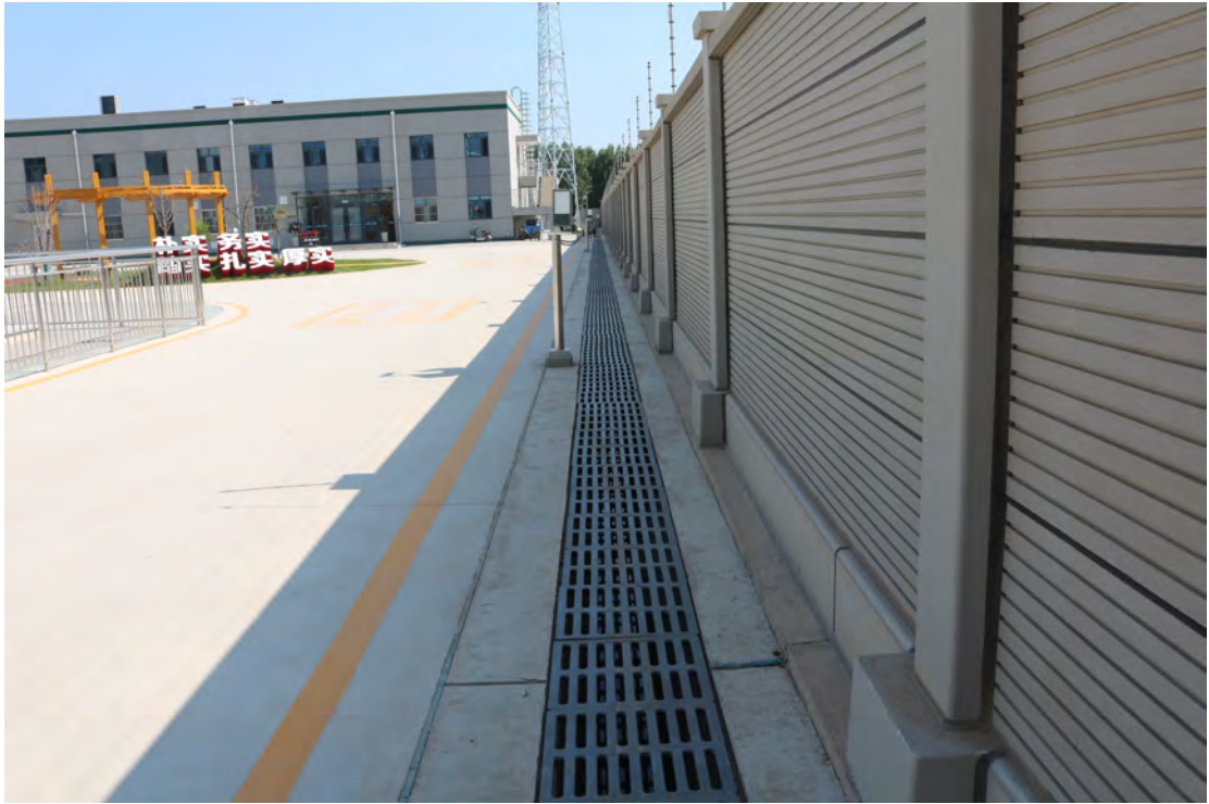
变电站铺设排水管（2022 年 6 月）
