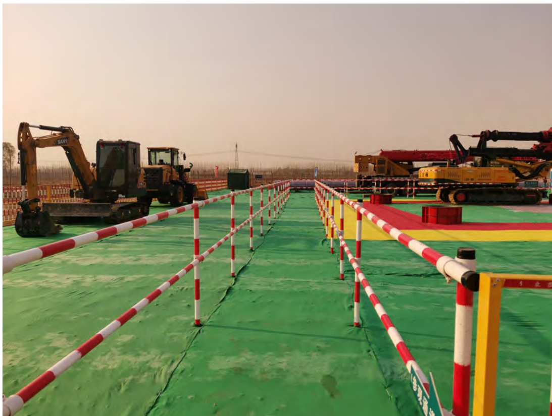
输电线路塔基施工区临时遮盖（2020 年 3 月）
