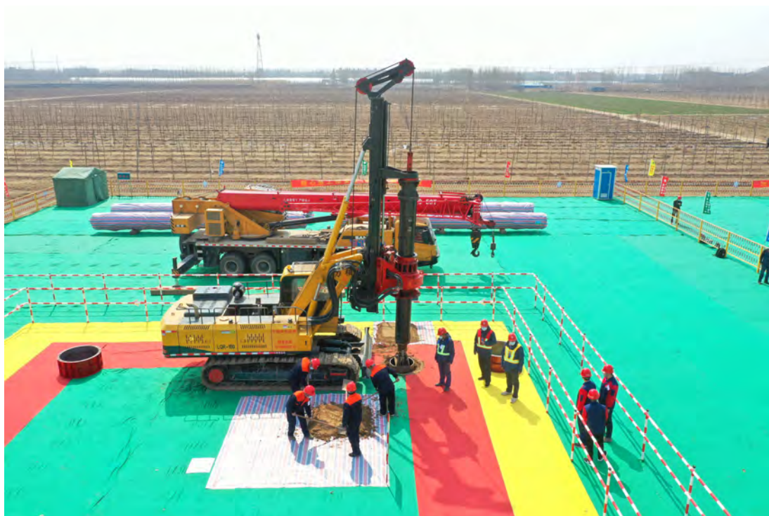
输电线路塔基施工区临时遮盖（2020 年 3 月）
