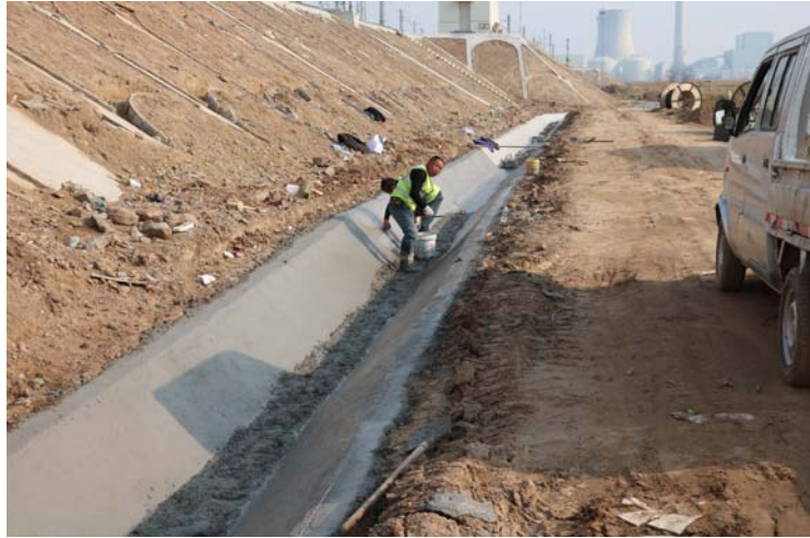
拱形骨架护坡及浆砌石排水沟（2019.11.29）
