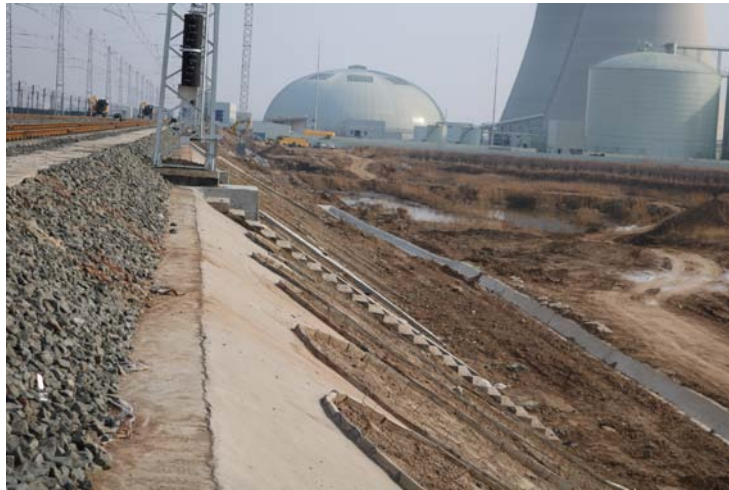
拱形骨架护坡及浆砌石排水沟（2019.11.29）
