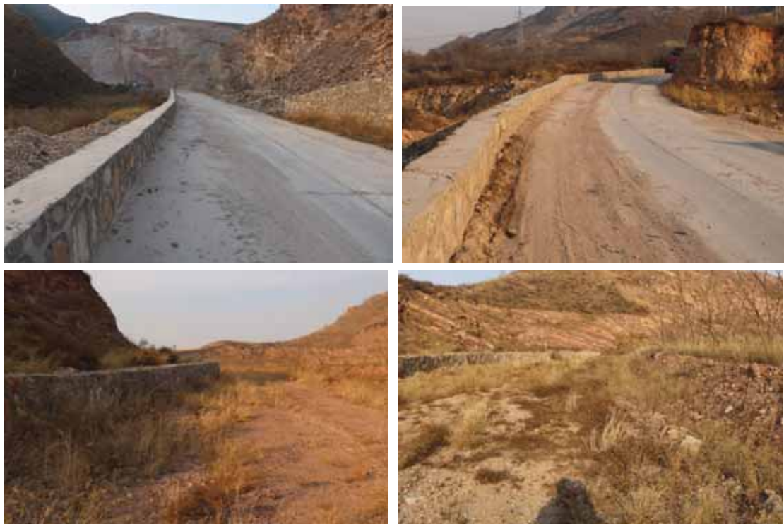
道路浆砌石挡墙、道路边埂
