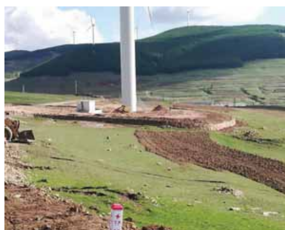
风机区覆土平整、干砌石挡墙
