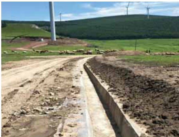
施工检修道路干砌石挡墙、边埂、覆土绿化栽植乔灌木
