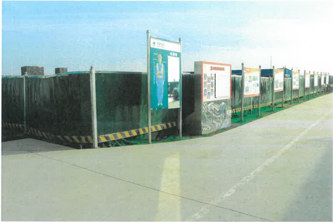
施工生产生活区临时遮盖
