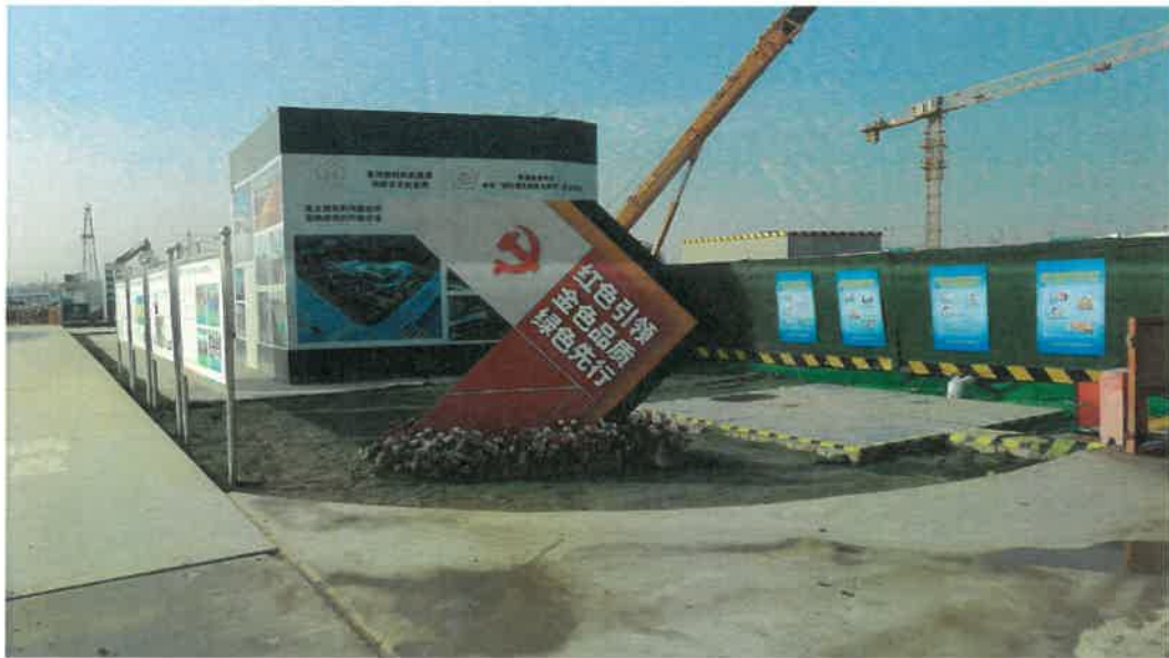
施工生产生活区临时绿化
