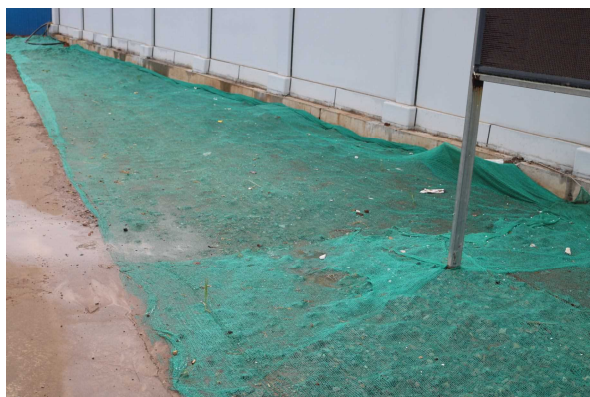
塔基施工区遮盖措施(2017 年 12 月)
