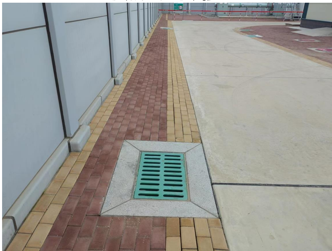
降水蓄渗工程（透水性便道砖）防洪排导工程（排水口）
