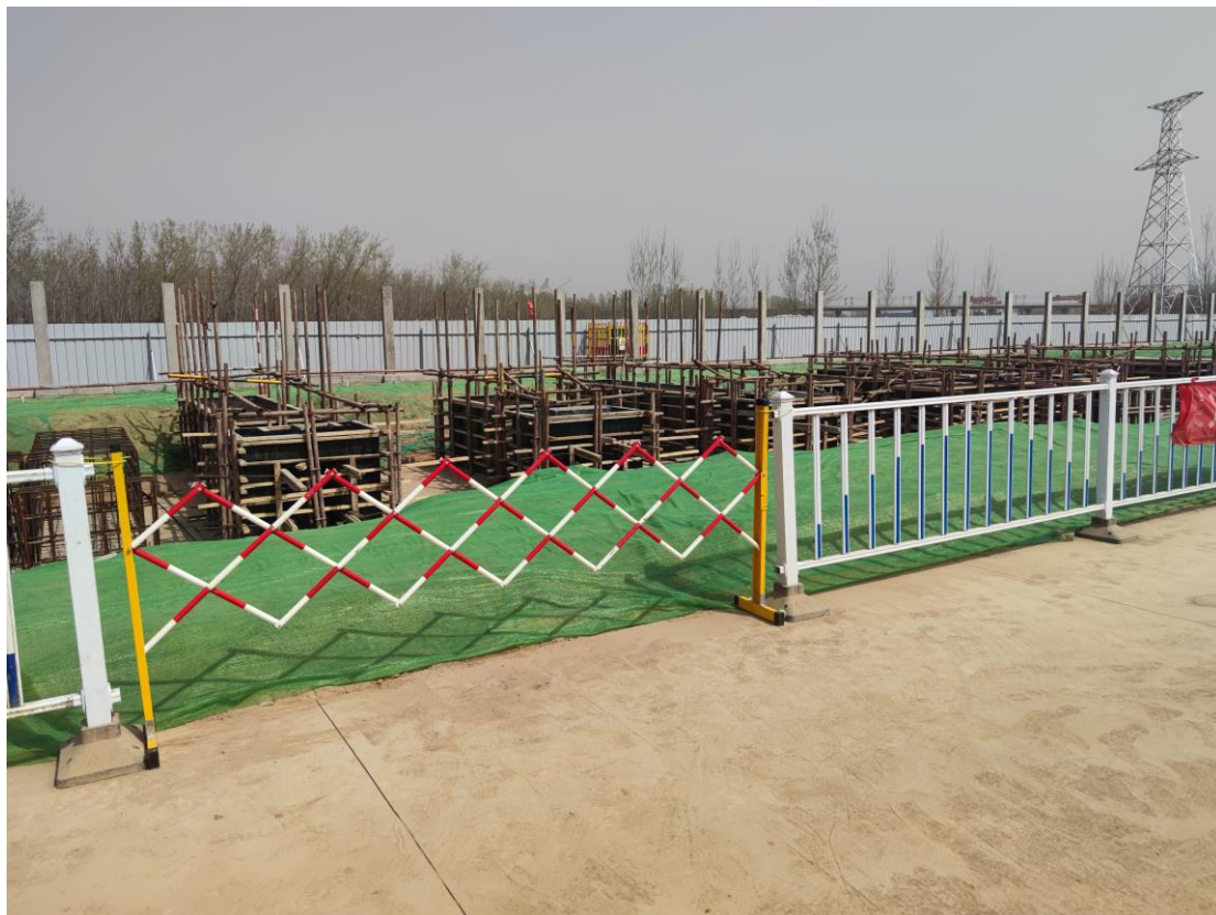
临时防护工程（临时遮盖、临时拦挡）
