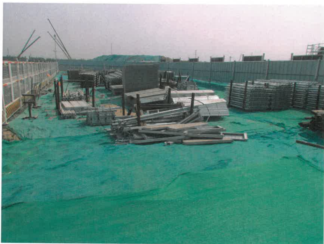
施工生产生活区临时遮盖
