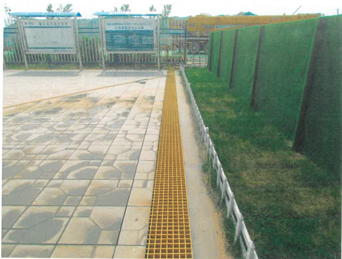
施工生产生活区临时排水沟
