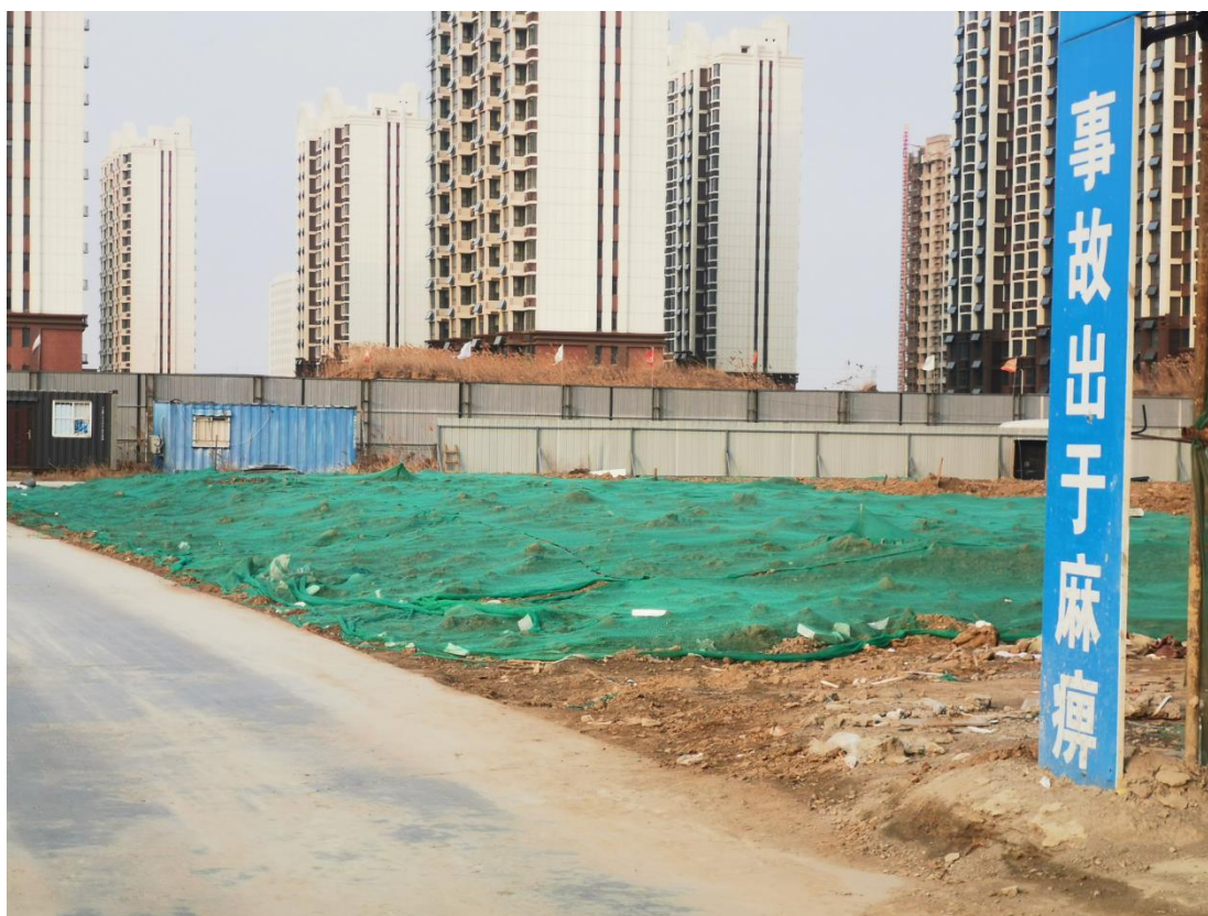
图 2-1 小区周边临时拦挡
