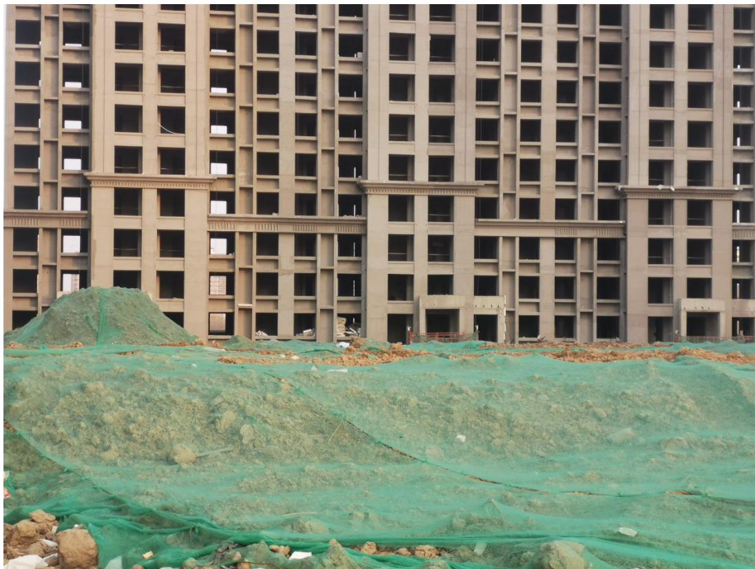
图 2-2 临时裸露地表苫盖
