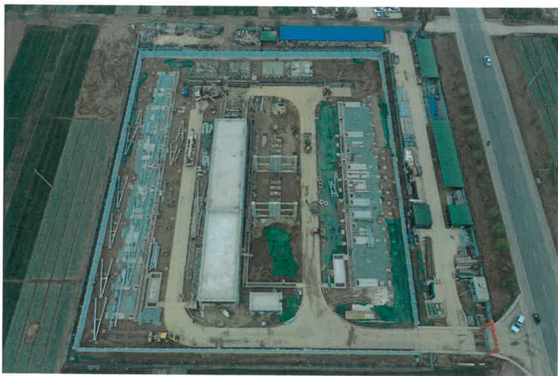
变电站做好临时排水措施
