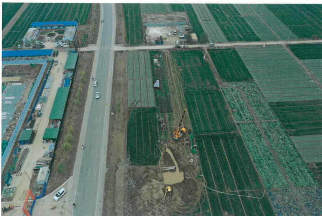
输电线路清理表土及时进行遮盖
