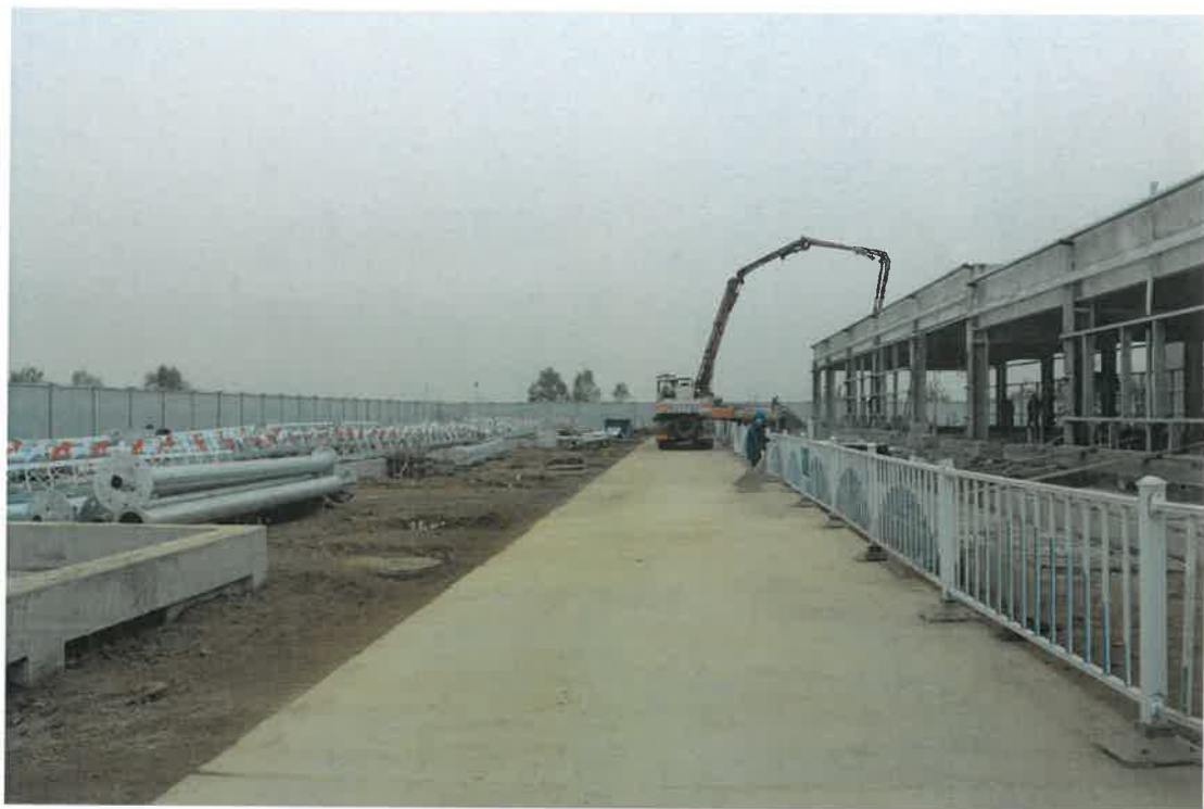
变电站做好临时遮盖措施
