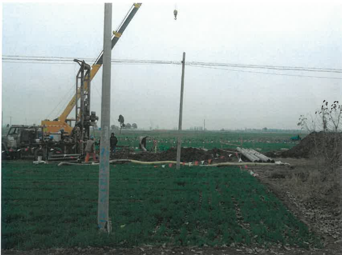
输电线路清理表土及时进行遮盖
