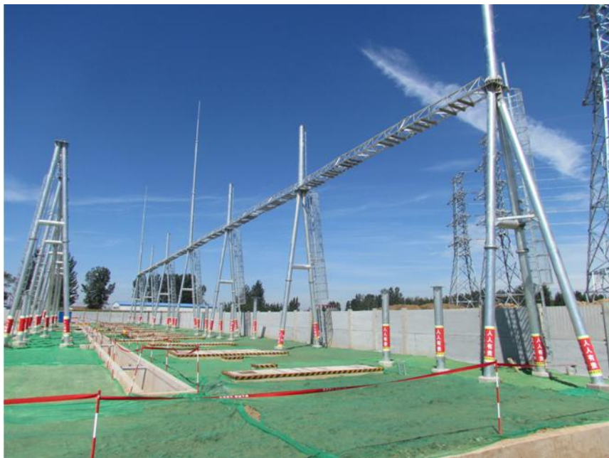
图 4-1 变电站内裸露地表遮盖
