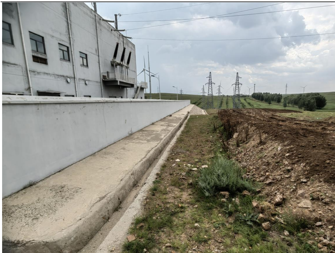
220kV 变电站防洪排导工程（排水系统）(2022.7)
