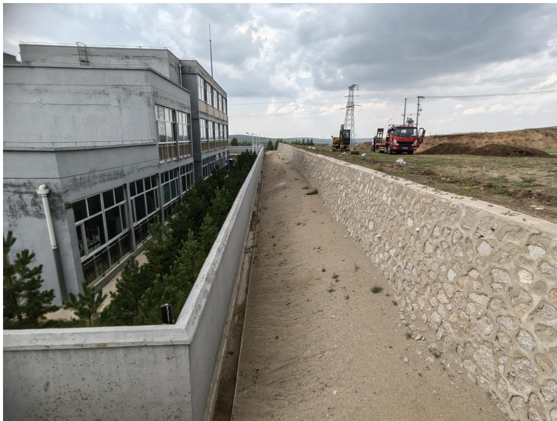
220kV 变电站斜坡防护工程（浆砌石挡墙）（2022.7）
