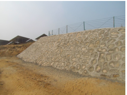
施工检修道路浆砌石排水沟、护坡
