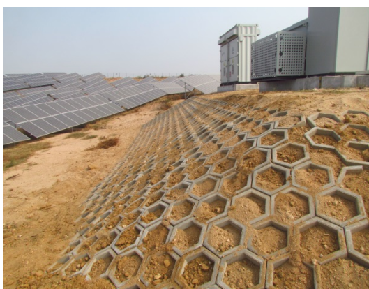
箱变逆变器植被恢复及边坡防护
