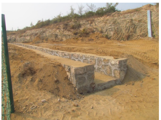
施工检修道路浆砌石排水沟、护坡
