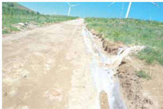
施工检修道路排水沟
