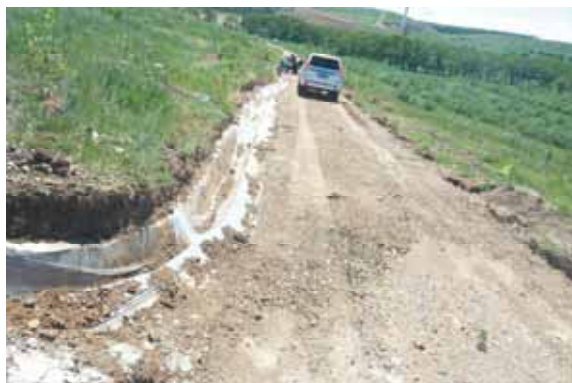
施工检修道路排水沟
